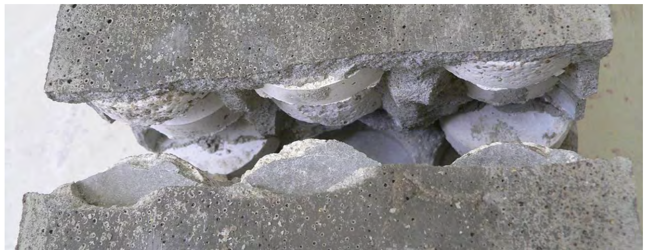
1. Rissverlauf quer über die Zugseite des Probekörpers
