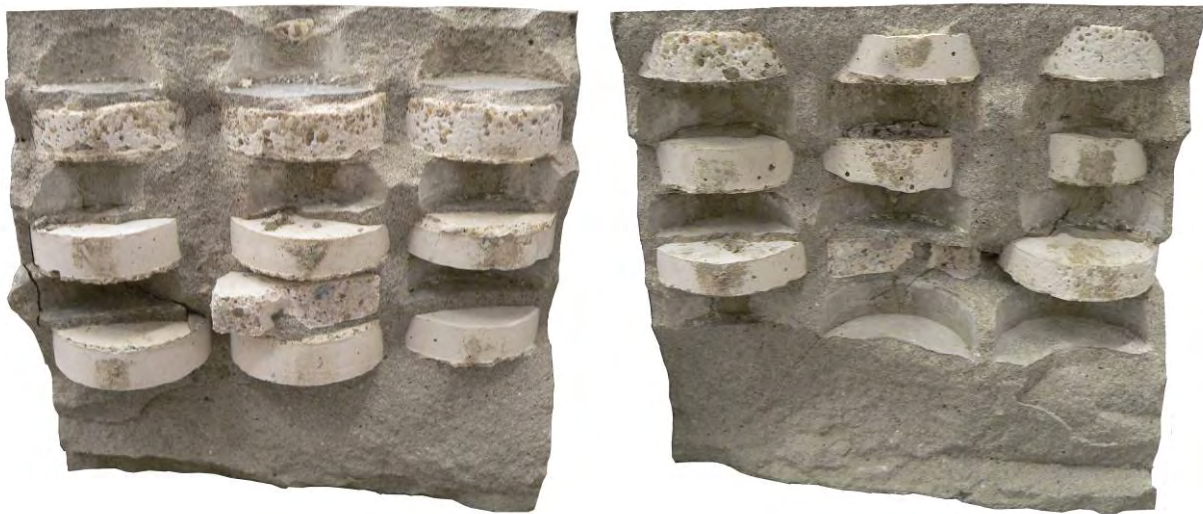
Abb. 103: Bruchfläche von PK 10; linkes Bild: linkes Rissufer; rechtes Bild: rechtes Rissufer
