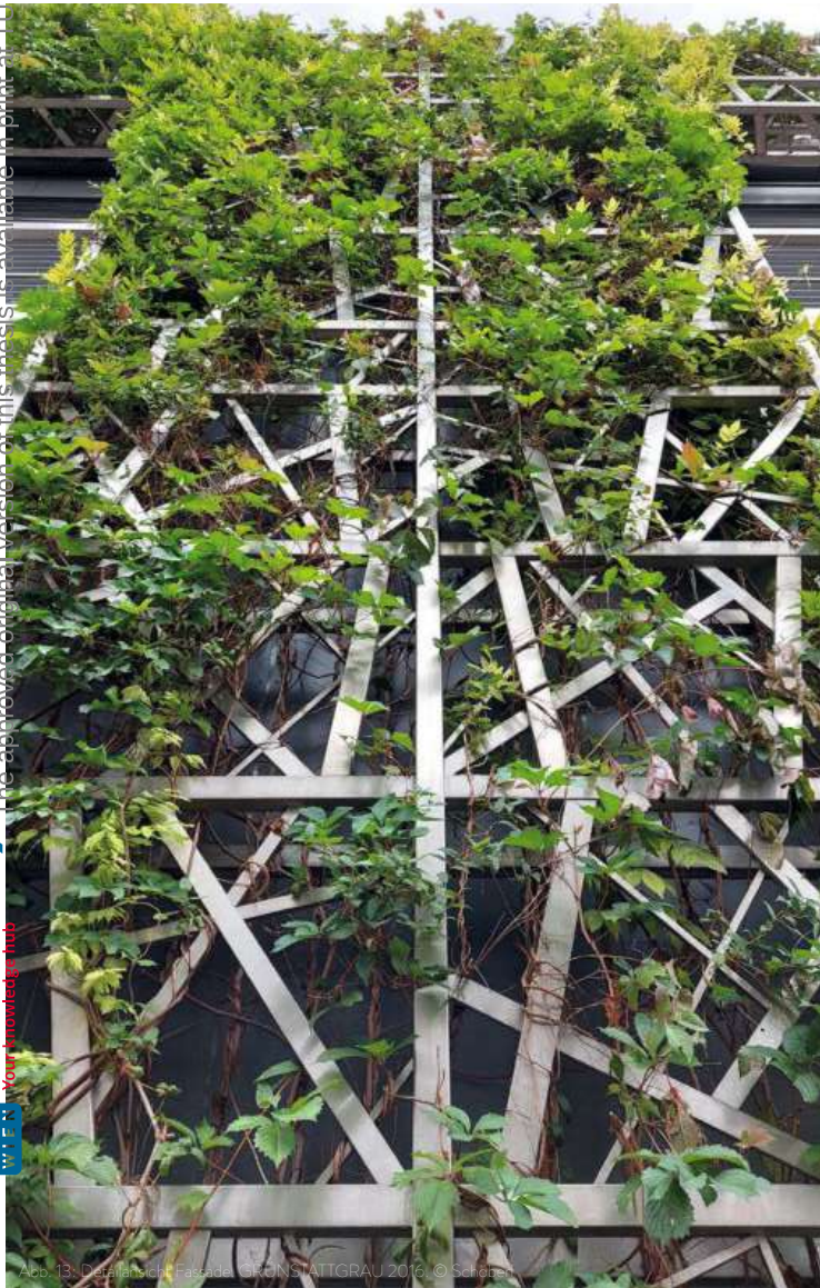
Abb. 13: Detailansicht Fassade, GRUNSTATIGRAU 2016, © Schöberl.
