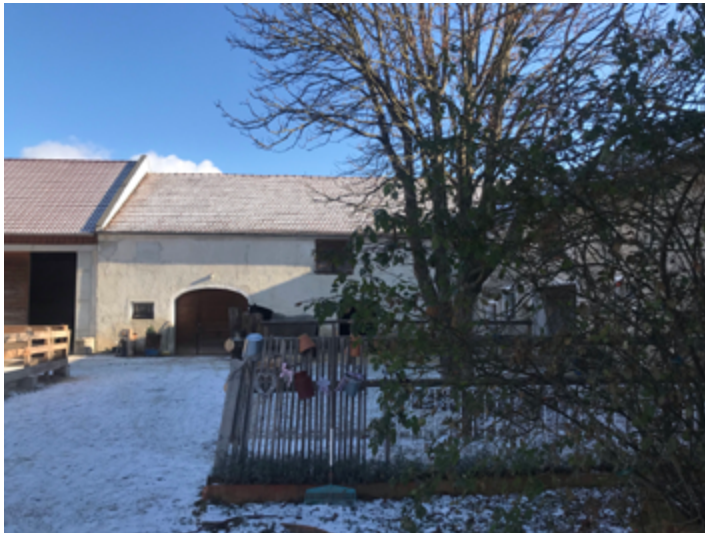
Abb. 4.90 Bestandsgebäude Stallungen, Hofansicht
