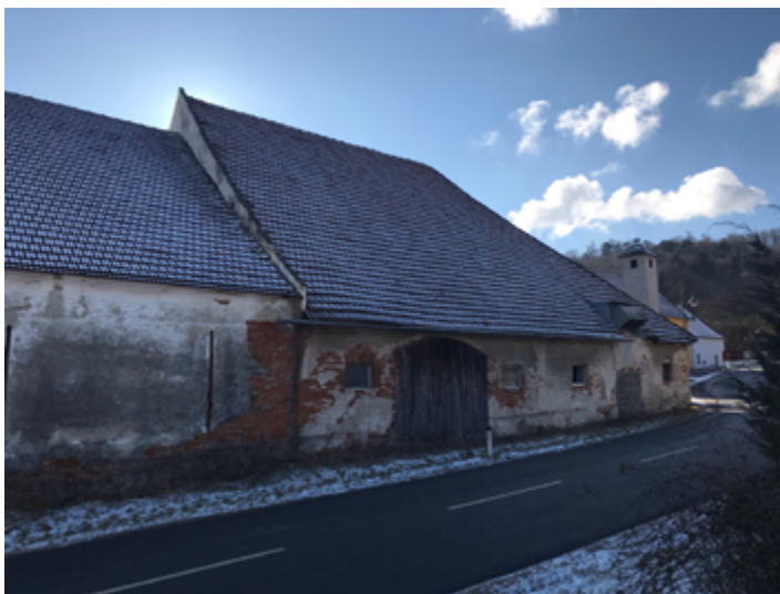
Abb. 4.79 Bestandsgebäude Stallungen, Straßenansicht
