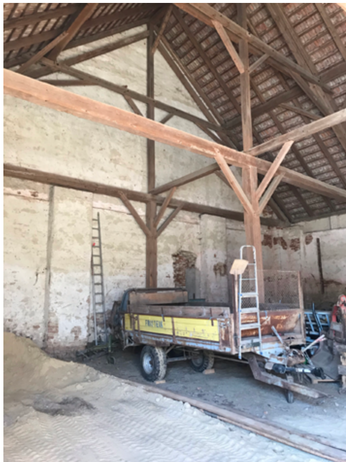
Abb. 4.85 Bestandsgebäude Halle, Innenraum
