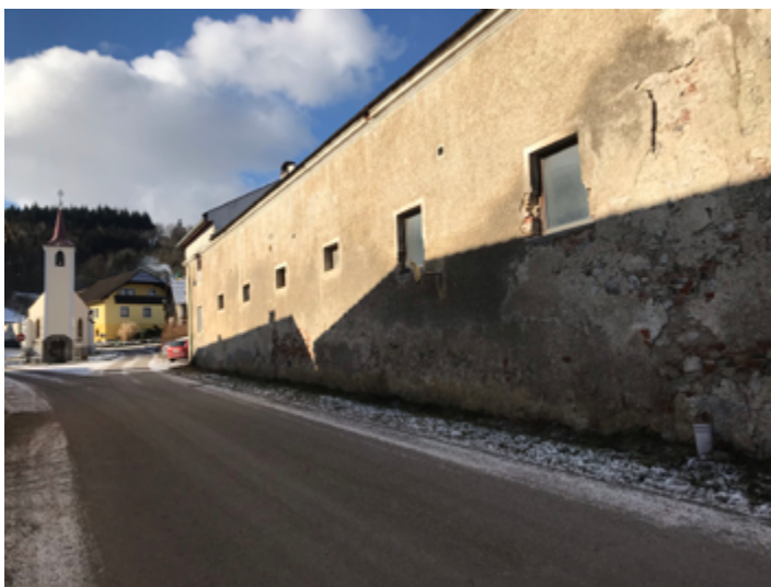
Abb. 4.92 Bestandsgebäude Stallungen, Straßenansicht
