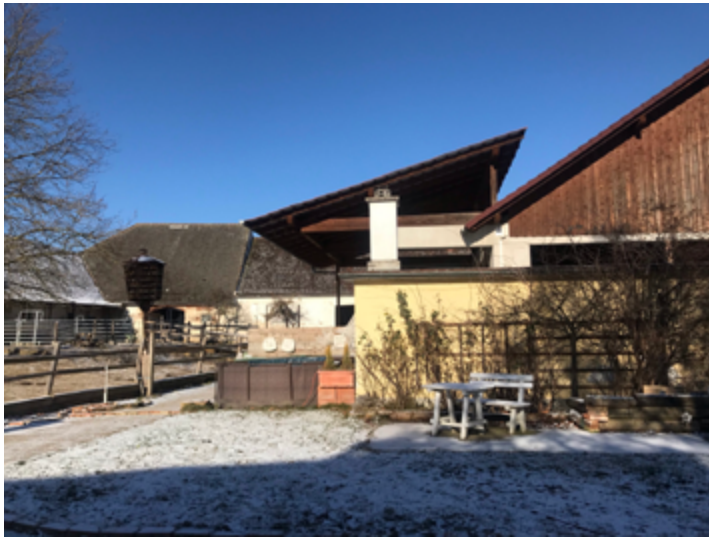
Abb. 4.94 Bestandsgebäude Einstellplatz, Überdachung
