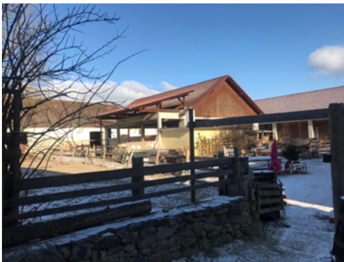
Abb. 4.91 Bestandsgebäude Einstellplatz, Hofansicht
