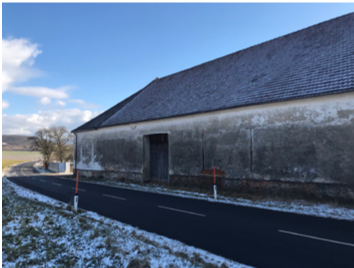
Abb. 4.84 Bestandsgebäude Halle, Straßenansicht
