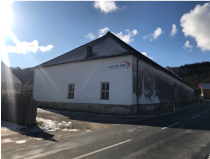
Abb. 4.83 Bestandsgebäude Halle, Straßenansicht
