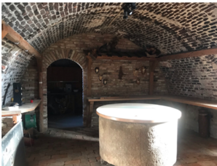
Abb. 4.72 Bestandsgebäude Wohntrakt, Gewölbekeller
