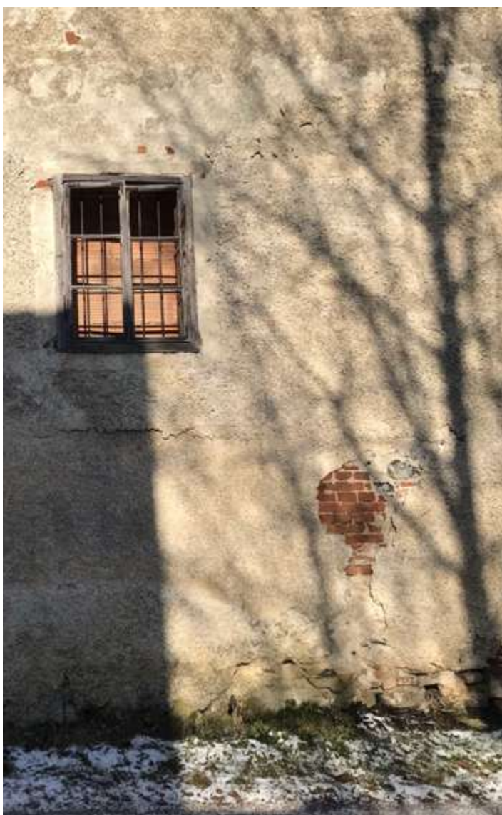
Abb. 4.93 Bestandsgebäude Stallungen, Fassade
