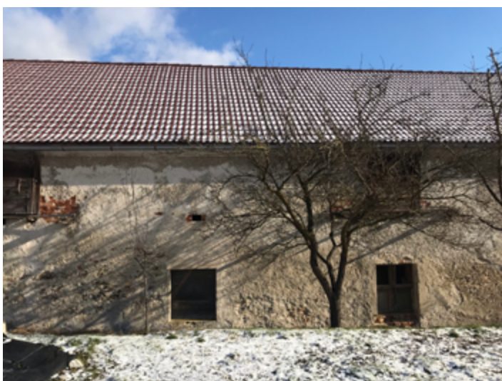
Abb. 4.80 Bestandsgebäude Stallungen, Straßenansicht
