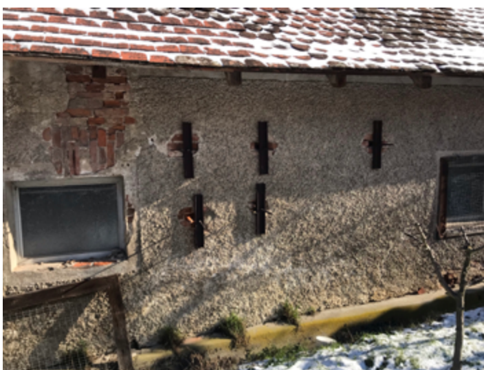
Abb. 4.81 Bestandsgebäude Stallungen, Eisenanker
