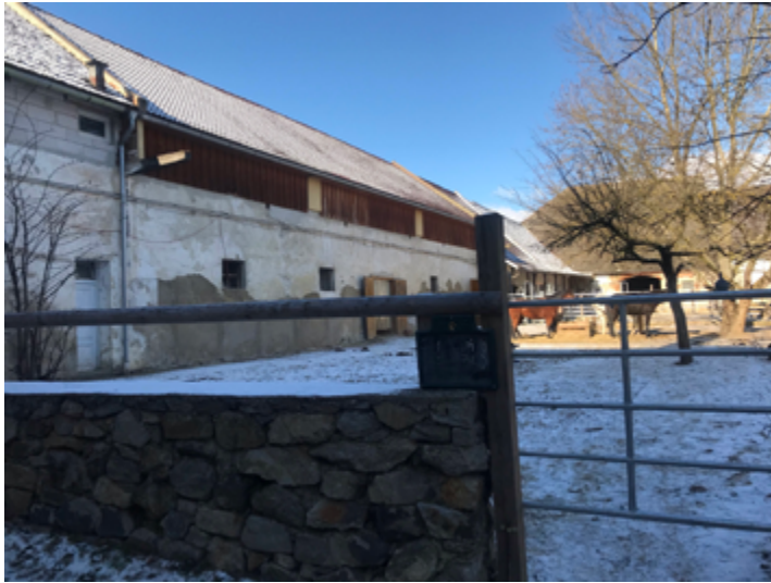
Abb. 4.76 Bestandsgebäude Stallungen, Hofansicht
