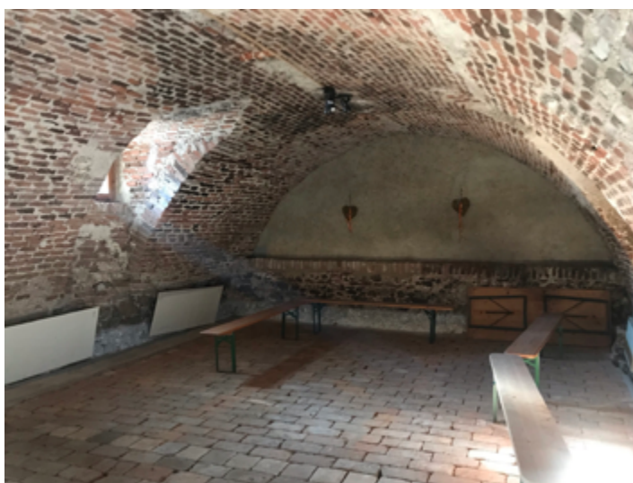
Abb. 4.73 Bestandsgebäude Wohntrakt, Gewölbekeller
