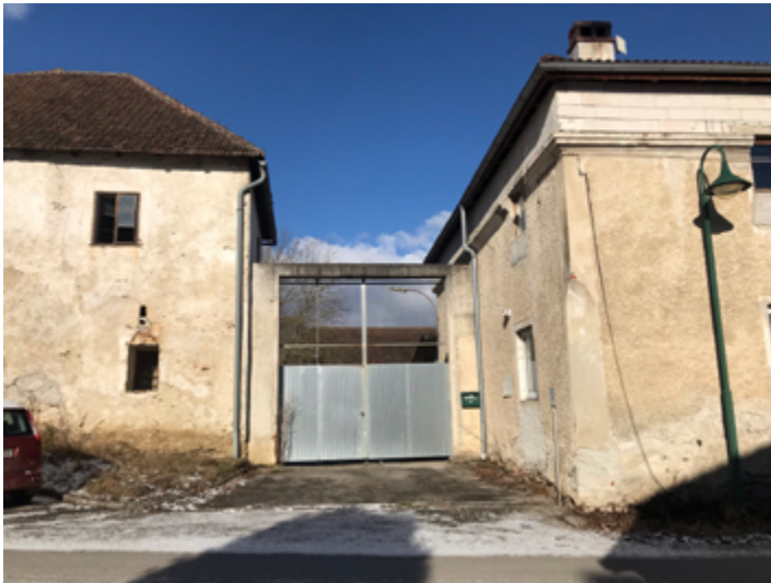
Abb. 4.70 Bestandsgebäude Toreinfahrt, Straßenansicht
