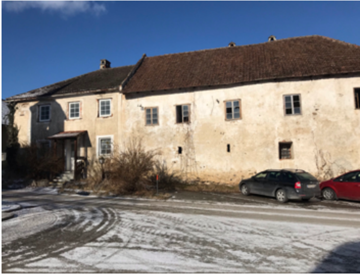
Abb. 4.69 Bestandsgebäude Wohntrakt, Straßenansicht
