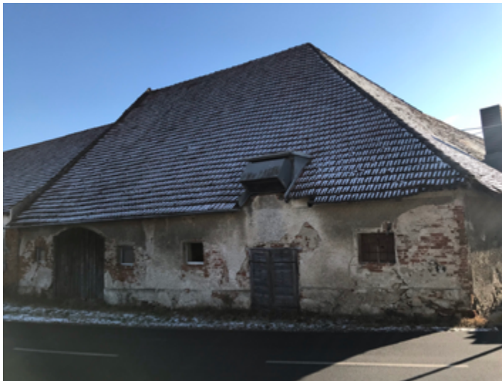
Abb. 4.77 Bestandsgebäude Stallungen, Straßenansicht
