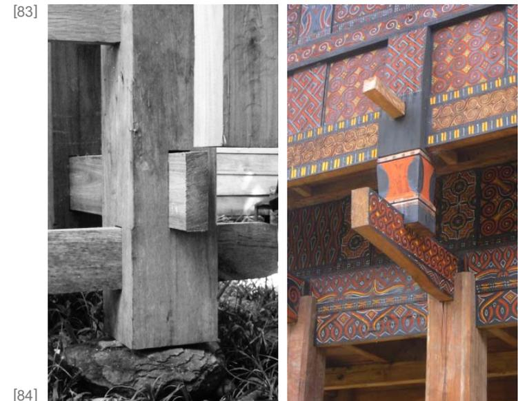
Abb.83+84: Details zum Pfosten-Riegel System.
