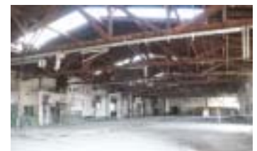
Die Halle Nord des ehemaligen Kabelwerkes (1120 Wien) besteht aus zwei Bereichen; im Bild die große Halle
