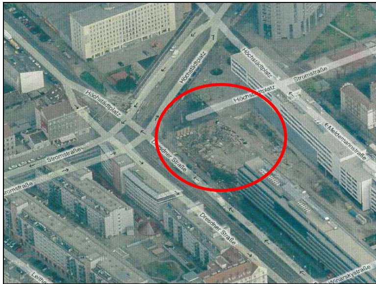
Abbildung 17: Orthofoto mit der bestehenden Baulücke
