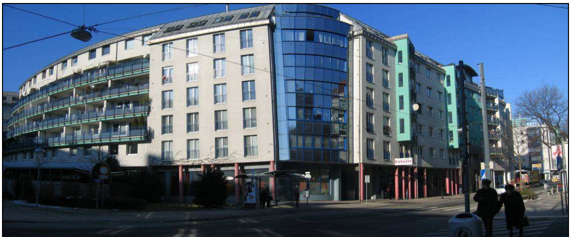
Foto: Straßenansicht Leystraße – Aignerstraße, eigene Produktion
