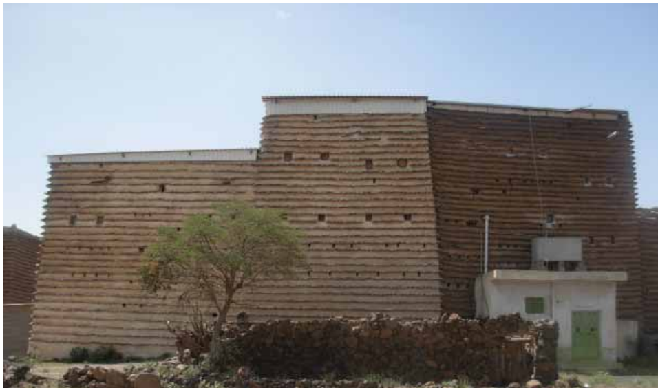
Abbildung 59: Stampflehmhaus mit Steinplatteneinlage (Beispiele, Siedlung 1)
