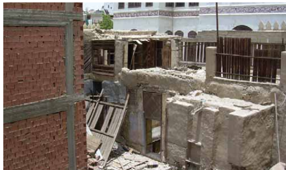
Abbildung 203: Blick hinter die Fassade
