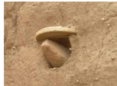
Abbildung 160: Mühlstein (links) und normaler Stein als Überlager
