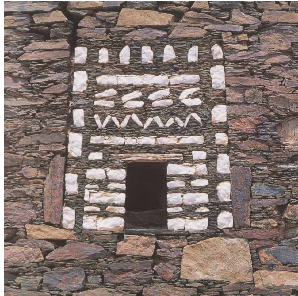
Abbildung 54: Steindekor an einem Wehrturm
