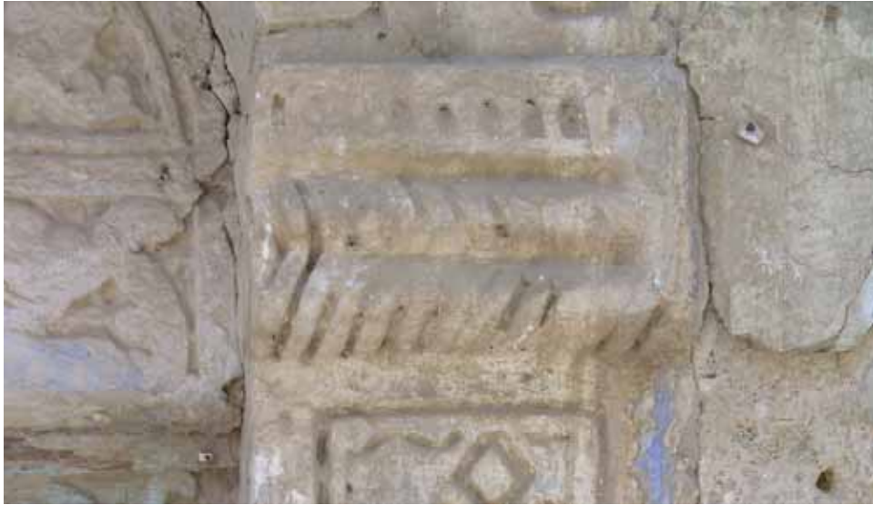
Abbildung 173: Farbreste an einem Türgewände in Jeddah
