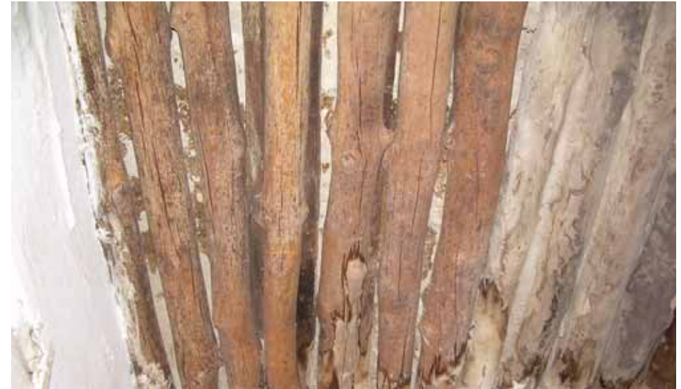
Abbildung 148: Typischer Deckenaufbau in Jeddah
