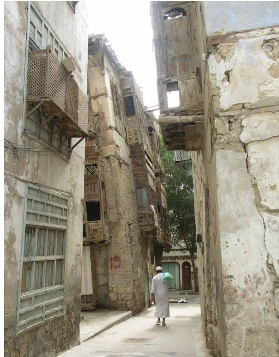
Abbildung 144: Beispiel für Setzungen und deren Auswirkung
