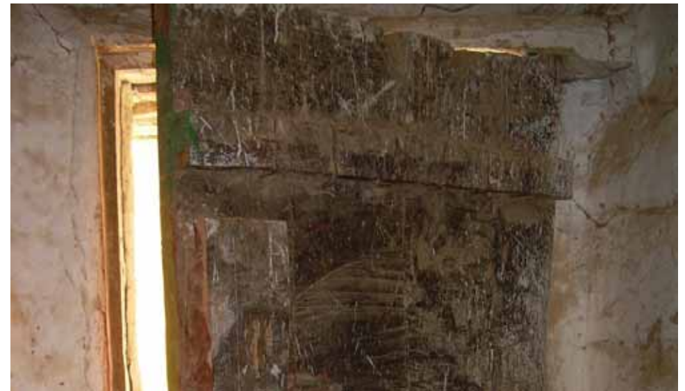
Abbildung 96: Konstruktionsprinzip der Türlagerung
