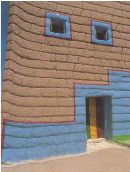
Abbildung 57: Wohnhaus in Stampflehmbauweise mit hochgezogenen Ecken
