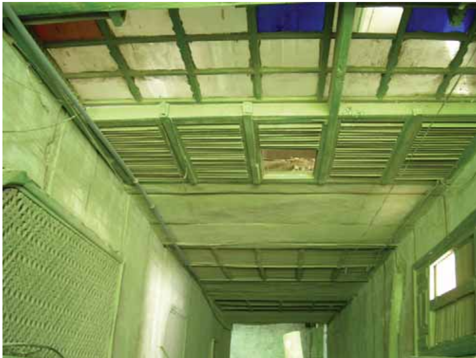
Abbildung 91: Luftschacht neben dem Treppenhaus (Jeddah)
