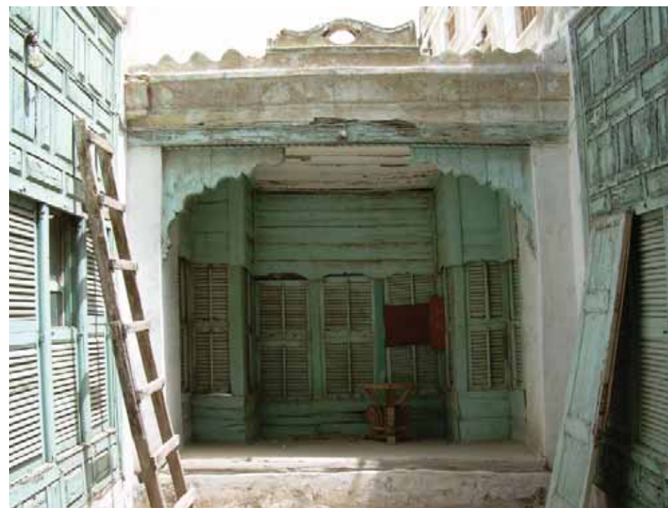
Abbildung 95: Haus mit „Ausnehmung“ in Jeddah
