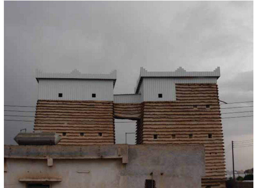
Abbildung 131: Brücke zwischen Gebäude 4 und 6 (siehe Beispiele)
