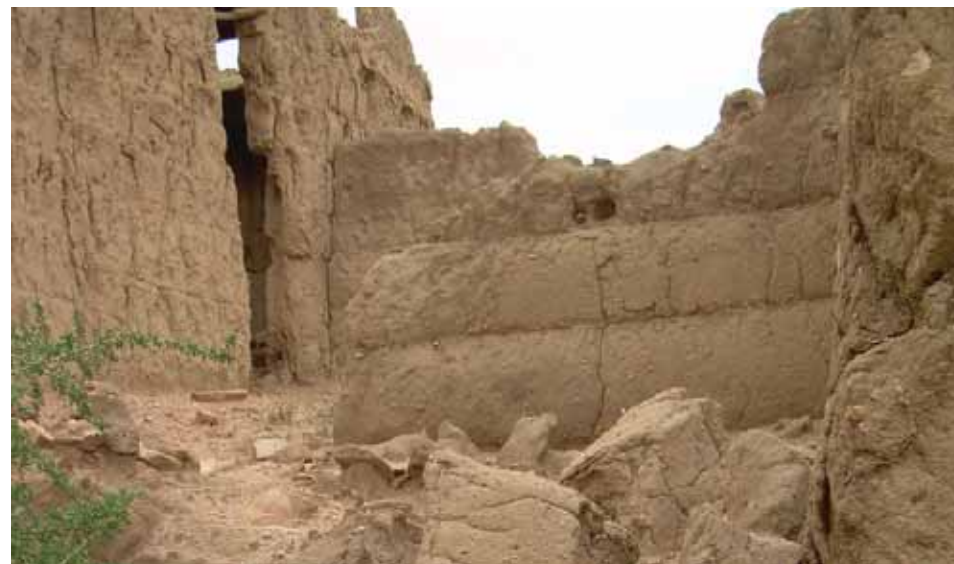
Abbildung 207: zu großen Brocken zerfallene Mauer (Siedlung 3, Al Bathah)
