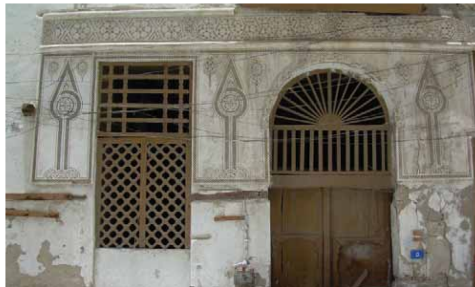
Abbildung 202: gut erhaltene Fassade mit Stuck
