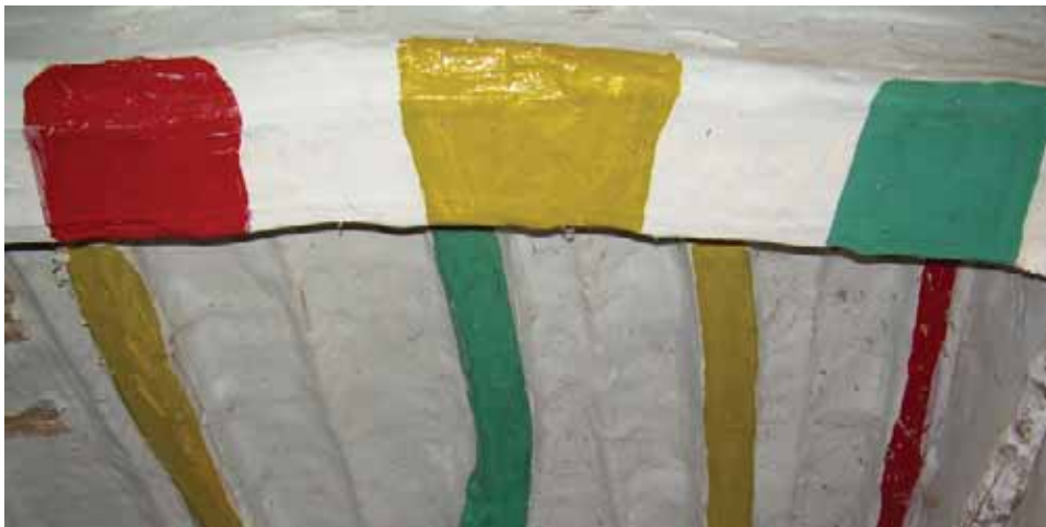
Abbildung 165: kolorierter Balken im Dachgeschoß
