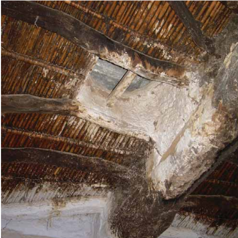
Abbildung 100: Küchendecke mit Rauchabzug
