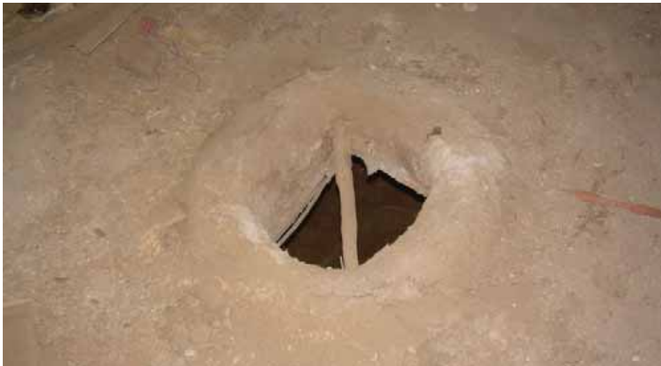
Abbildung 142: Dachluke mit Lehmwulst
