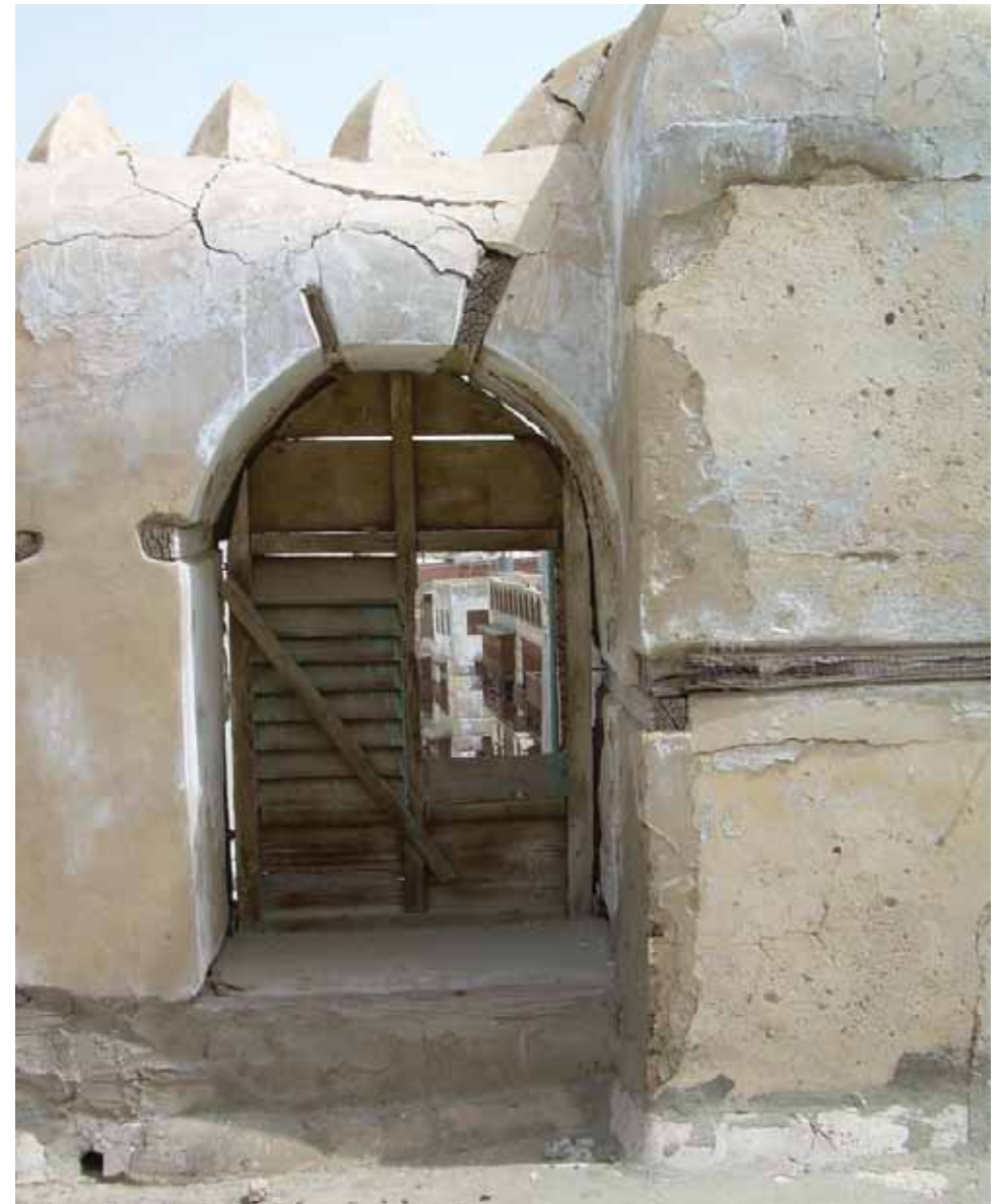
Abbildung 93: Brüstungs- und Begrenzungsmauern einer Dachterrasse in Jeddah
