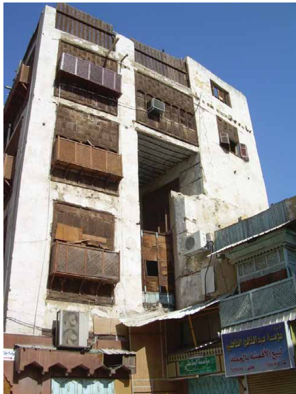
Abbildung 115: (Aufgestocktes?) Gebäude mit Einschnitt
