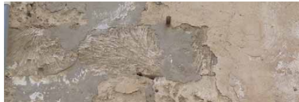
Abbildung 133: Korallenkalkstein, Detail einer Hauswand in Jeddah
