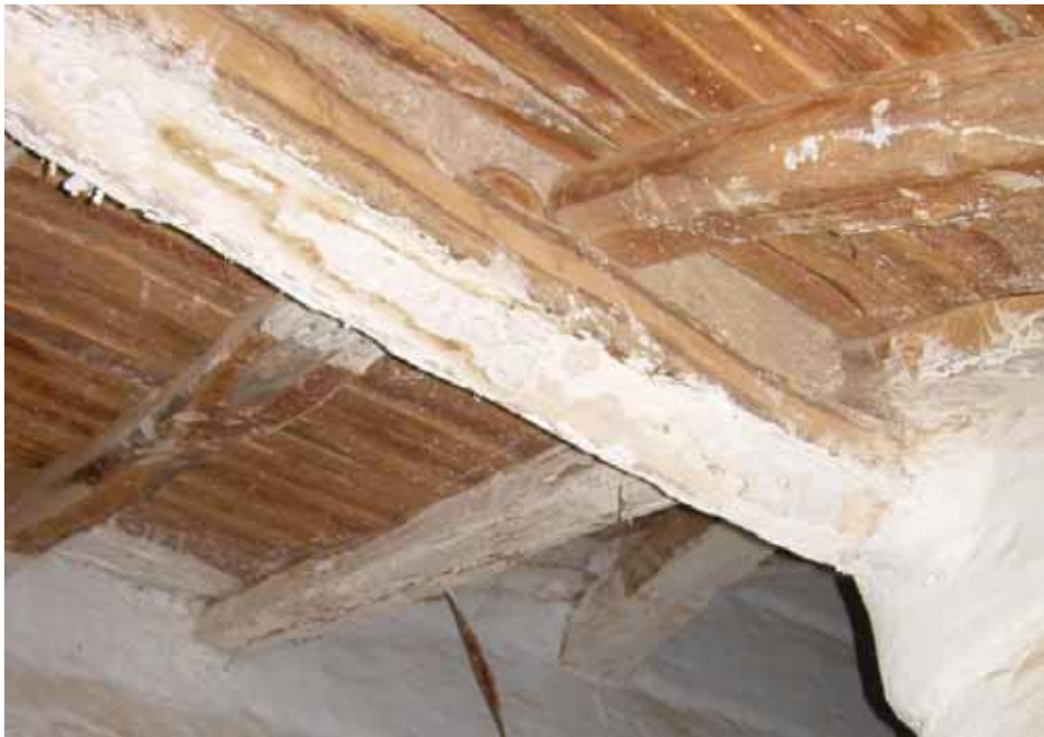
Abbildung 152: Deckenaufbau im Stiegenhaus
