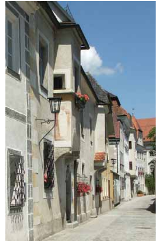
Abbildung 85: Europäischer „Erker“ mit seitlichem Guckloch (Steyr, Berggasse) In den Bauten des Jemen, konkret in Shibam sind vergleichbare Gucklöcher nach unten gerichtet, um die Straße im Blick zu haben.
