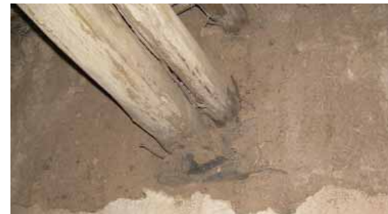
Abbildung 157: Balkenaufleger aus Steinplatten
