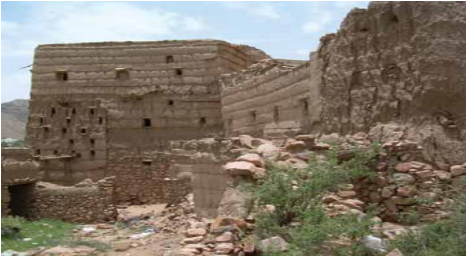
Abbildung 196: unterschiedliche Bautechniken in Al Batah
