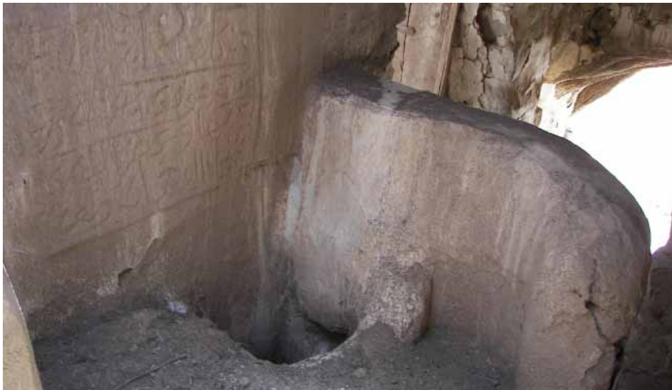
Abbildung 174: Putzrelief in Bereich der Zisterne von Gebäude 2
