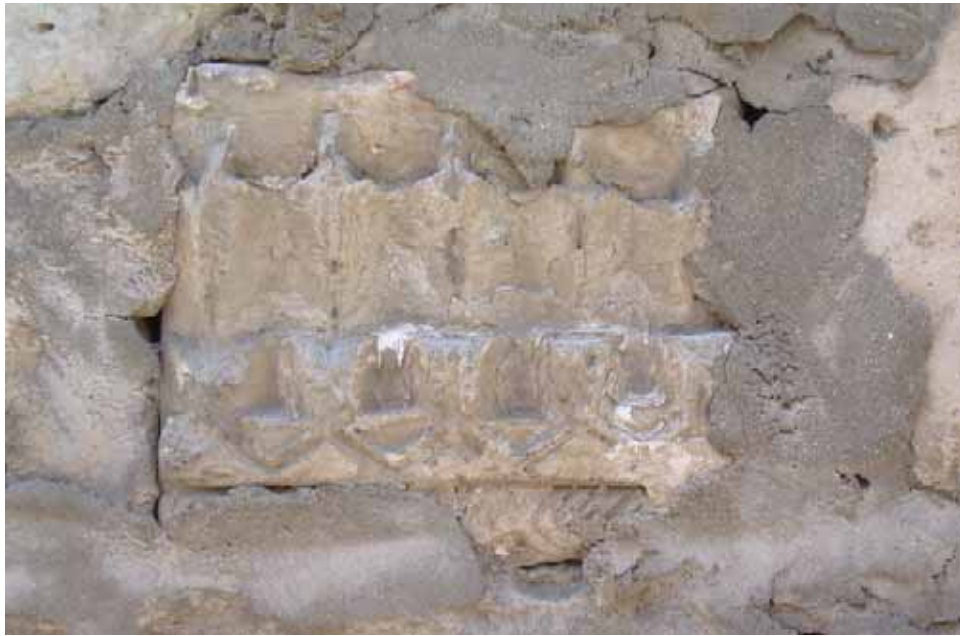
Abbildung 158: Auflagerstein, vermauert im Stadttor
