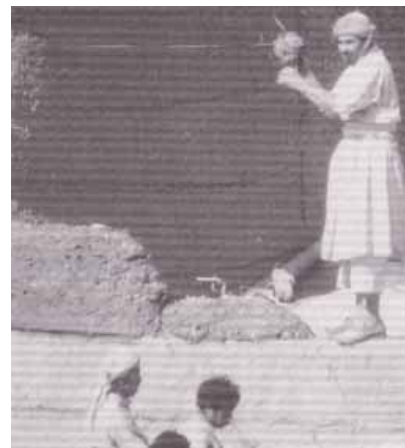
Abbildung 125: Midmak-Technik, Schnurgerüst
