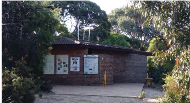
Abb.57 Sanitäranlagen des Campingplatzes
