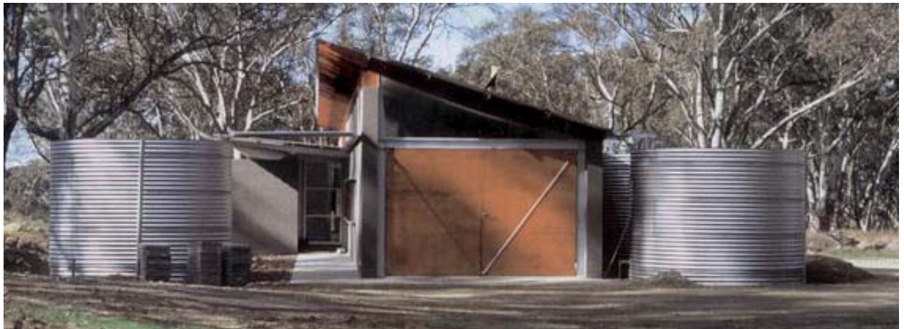
Abb.63 Haus mit Wassertanks von Glenn Murcutt
