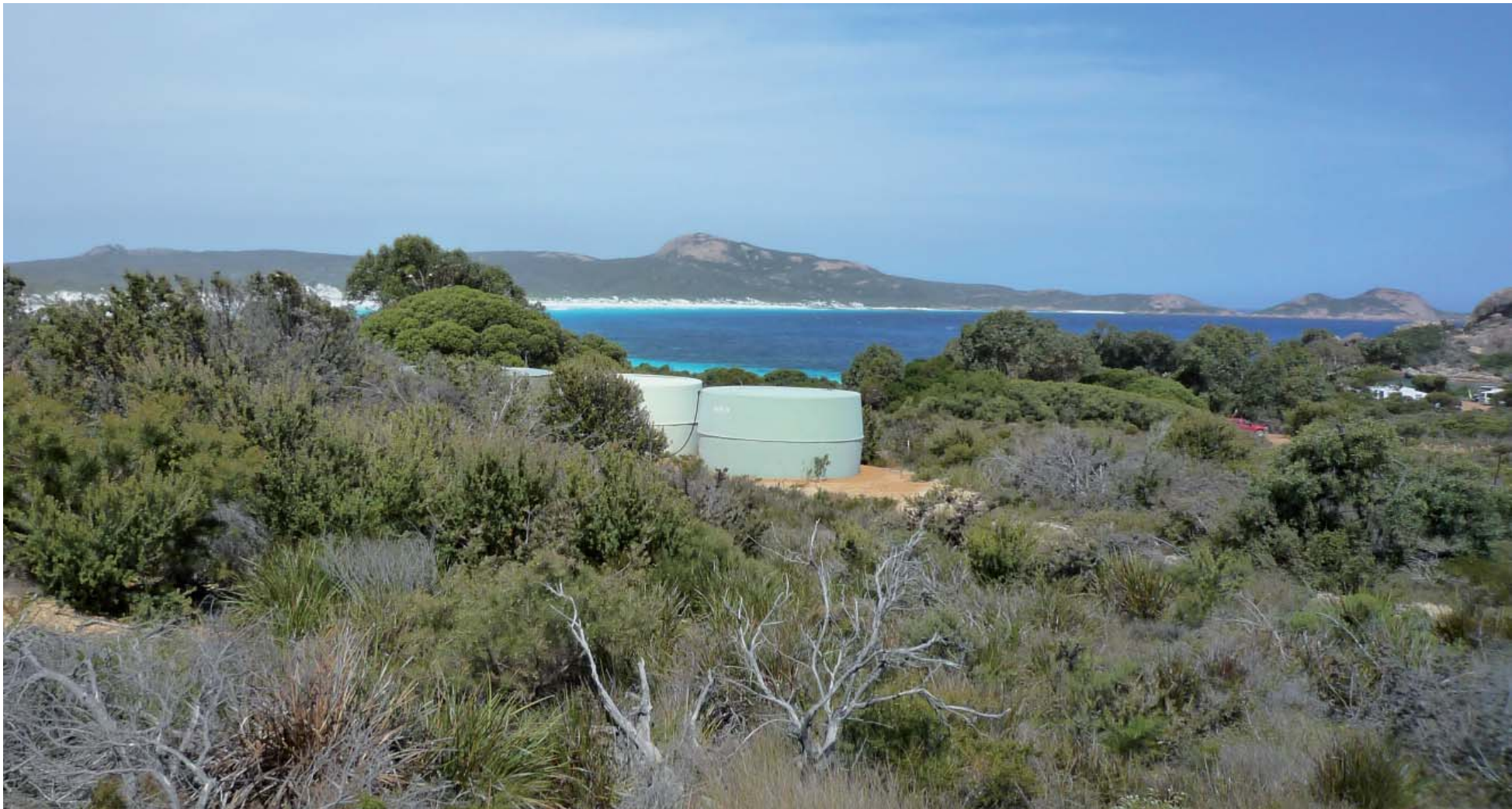
Abb.62 Wassertanks der Rangerunterkunft, 10 000 Liter, Lucky Bay
