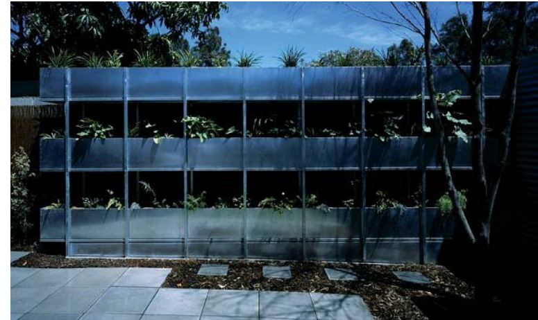
Abb.65 Vertikale Pflanzenfilteranlage eines Wohnhauses in Clovelly, New South Wales
