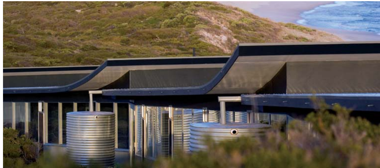
Abb.64 Wassertanks der Southern Ocean Lodge, Australien
