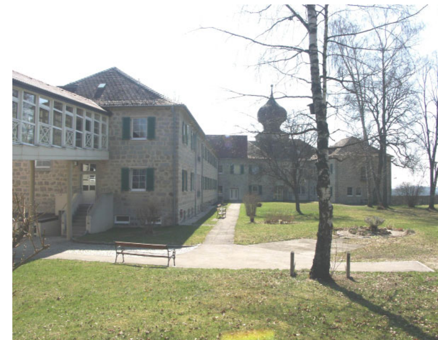
Abb. 70: Nordansicht Altbau mit Verbindungsbrücke
