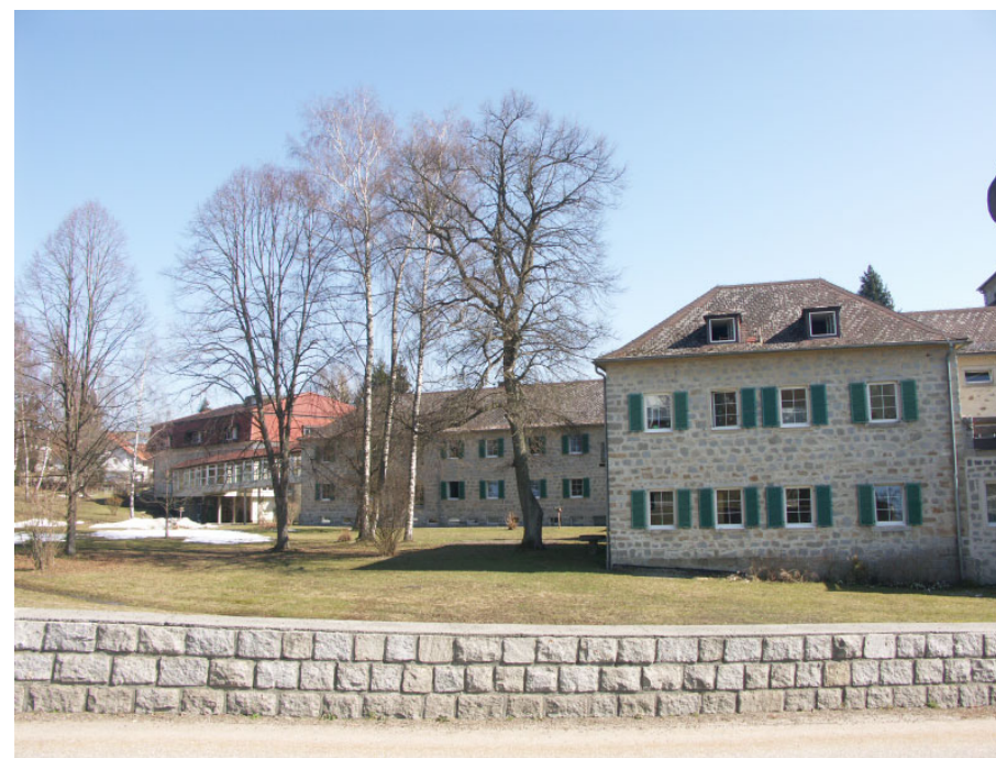
Abb. 69: Westansicht Alt- und Zubau
