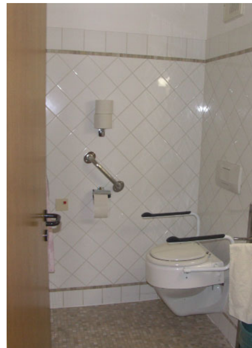
Abb. 43: Bad/WC Wohneinheit Bestand Altbau
