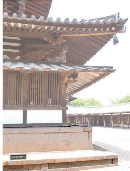
Abb. 123, Erdpodest mit Steinplatten verkleidet, Unterbau der Haupthalle Horyuji
