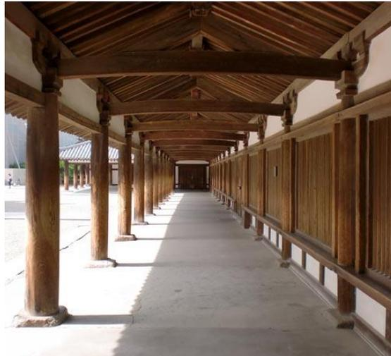
Abb. 46. Reihung der Module beim Umgang im Horyuji
