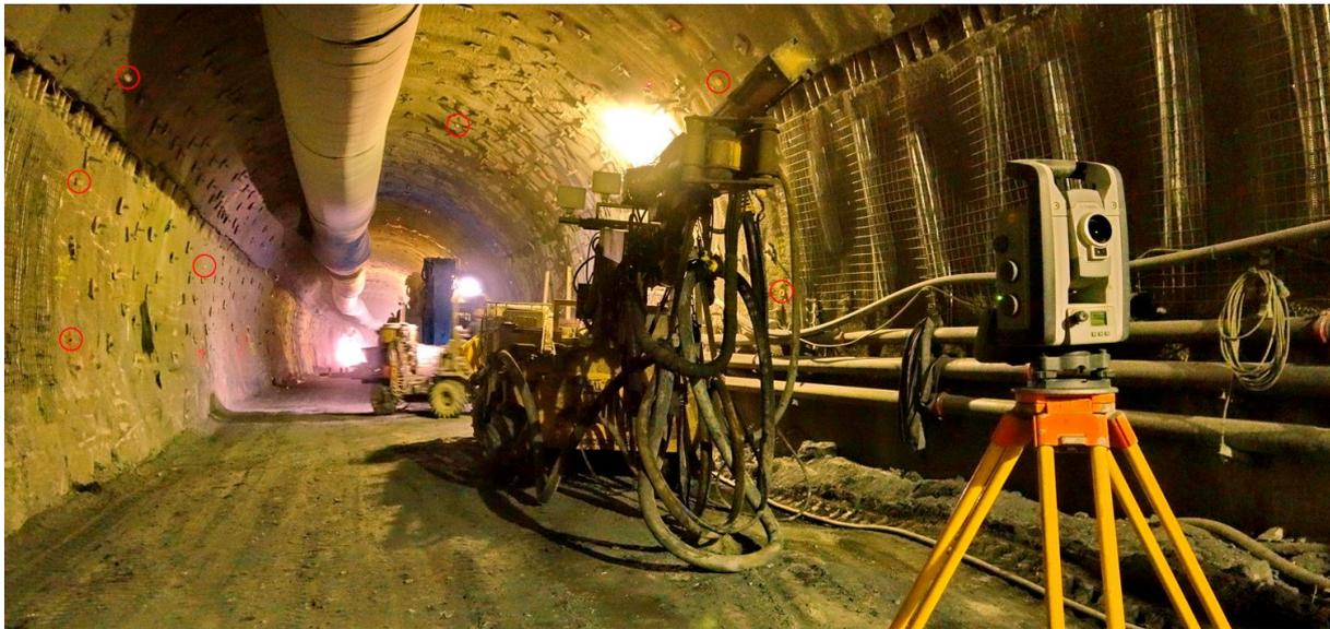
**Abb. 1.1:** Übersicht im Tunnel am Beispiel Semmering Basis Tunnel, in roten Kreisen sind unvollständig Zielmarken hervorgehoben
