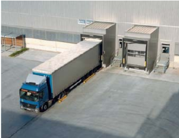
Abb. 15: Beispiel von LKW-Andockschleusen im LKW Werk Leipzig (Quelle: BMW 2008)
