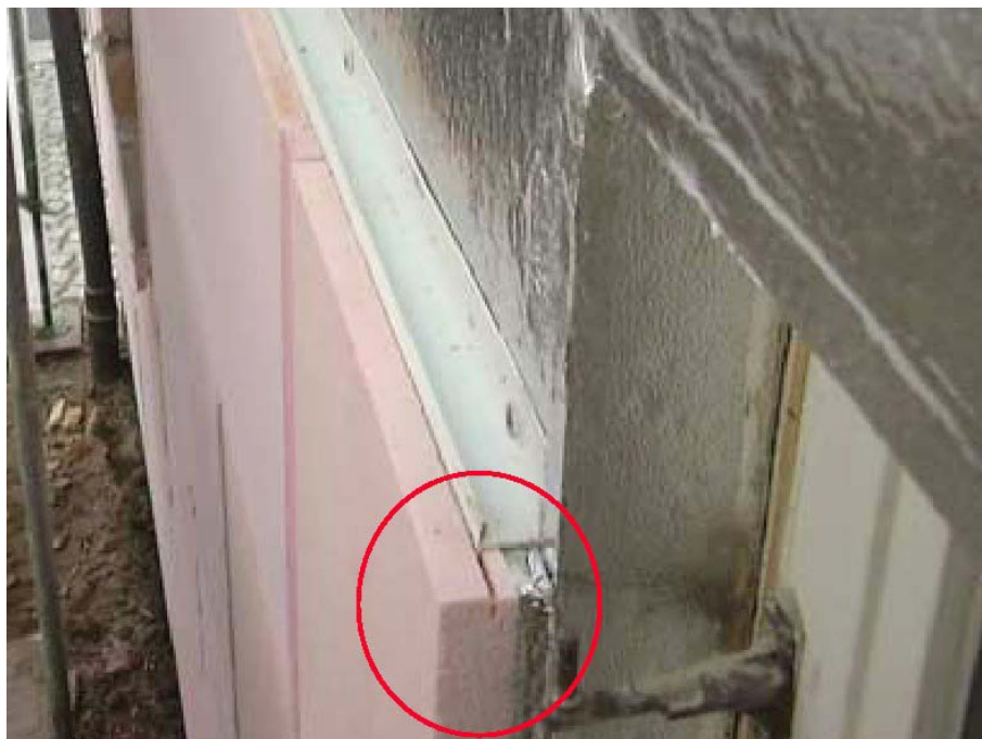
Abbildung 20: Praxisbeispiel – Befestigung der Paneele mittels Schienensystem, aus [14]
