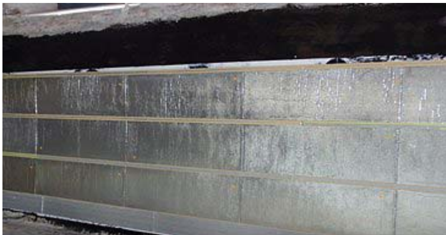
Abbildung 24: Praxisbeispiel – Befestigung der Paneele mittels Lattung, aus [39]
