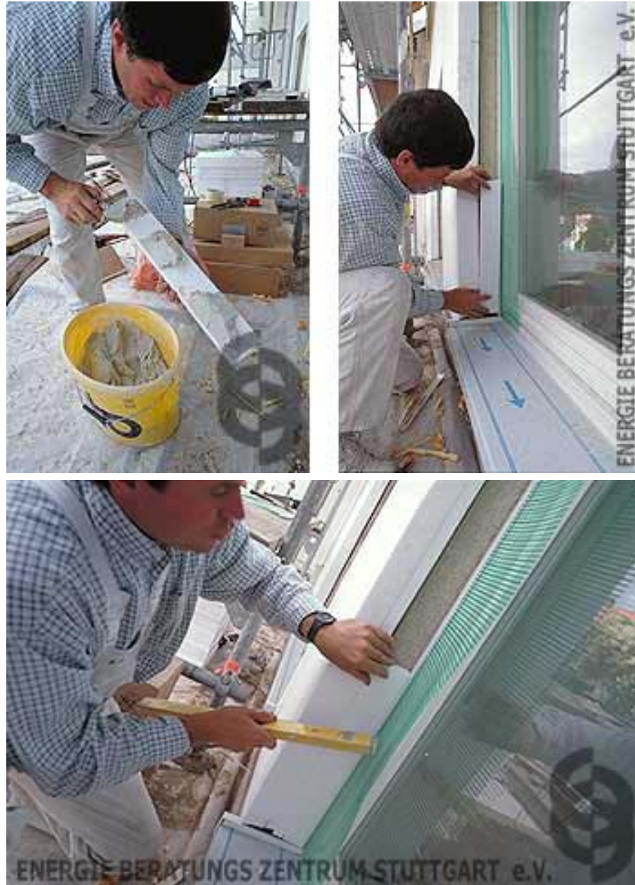
Abbildung 36: Praxisbeispiel – Leibungsdämmung außen, aus [55]
