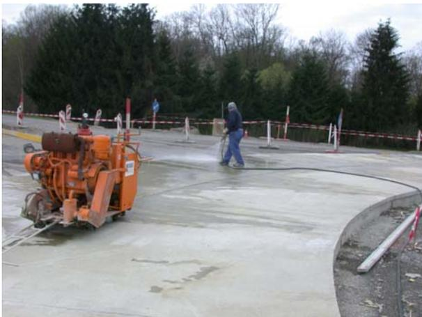
Abbildung 37: Fugenschnitt (Foto: VÖZ)
