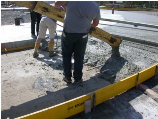
Abbildung 11: händischer, einschichtiger Einbau
