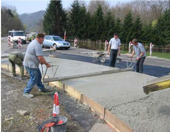
Abbildung 34: händischer Einbau
