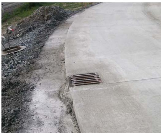
Abbildung 21: Schacht am Plattenrand
