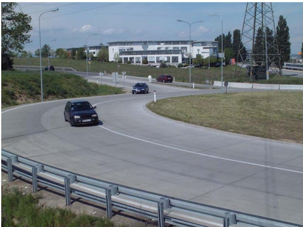
Abbildung C.4 Zweispurige KVA mit Betonfahrbahndecke, Standort: Schwechat, NÖ (Foto: VÖZ)
