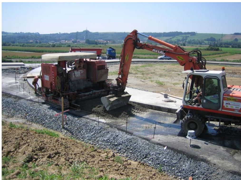
Abbildung C.2 Maschineller Einbau der Betonfahrbahndecke (Foto: SCHÖLLER)
