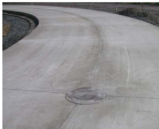
Abbildung 22: Schacht im Plattenkreuz
