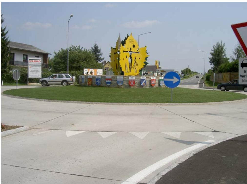
Abbildung C.5 Einstreifige KVA mit Betonfahrbahndecke, Standort: Kaindorf / Sulm, Steiermark (Foto: WEDL)
