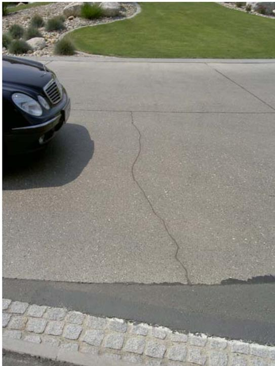
Abbildung 57: Plattenbruch (Foto: WEDL)
