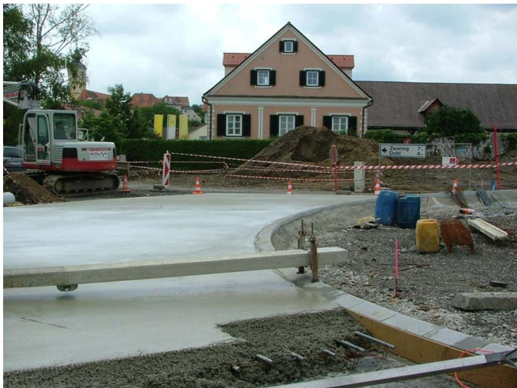
Abbildung C.1 Händischer Einbau der Betonfahrbahndecke (Foto: SCHÖLLER)
