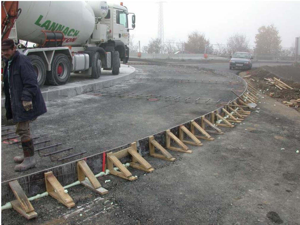
Abbildung C.3 Schalung und Dübelanordnung vor händischen Einbau des Fließbetons (Foto: SCHÖLLER)
