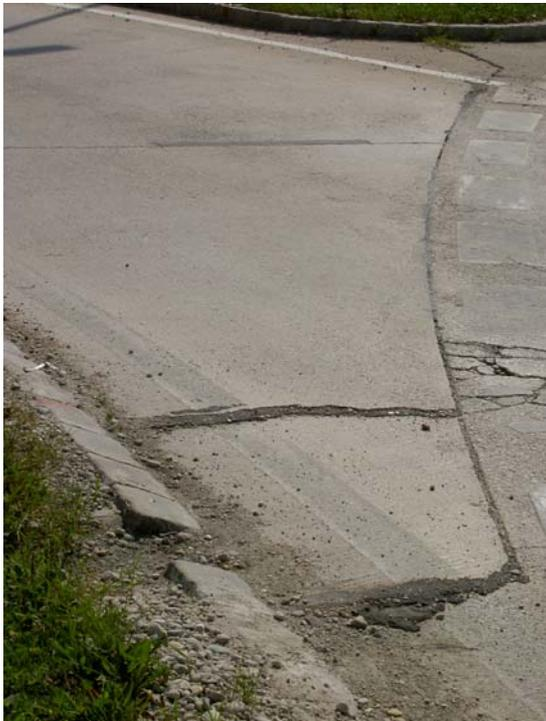
Abbildung 58: unregelmäßig geformte Betonplatte – Plattenbruch (Foto: WEDL)
