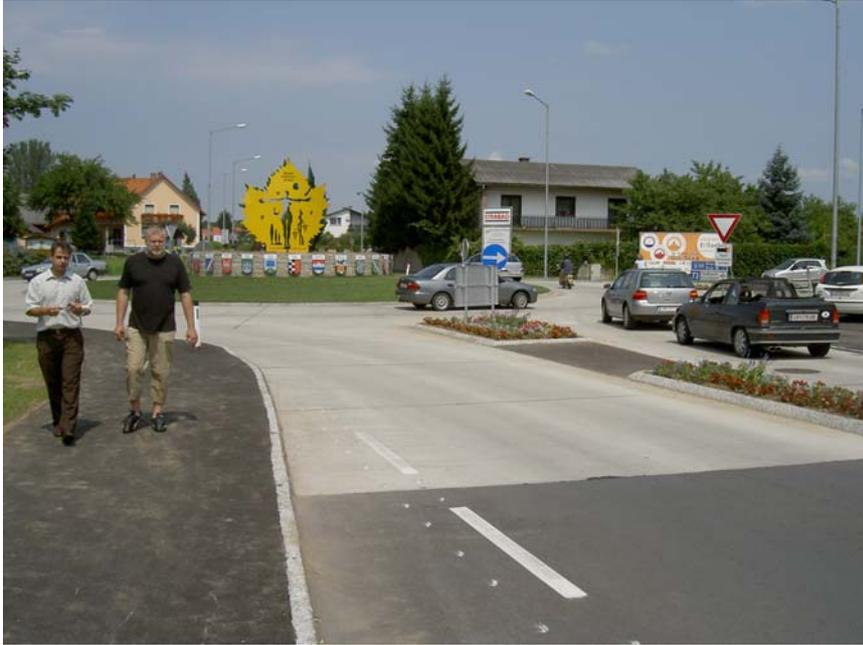
Abbildung 3: Helle Oberfläche des Betons erhöht die Verkehrssicherheit
