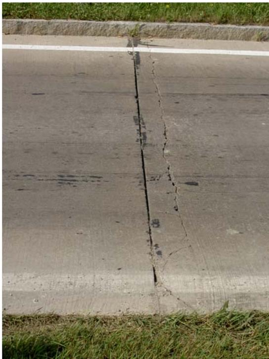
Abbildung 59: unregelmäßig geformte Betonplatte – Plattenbruch (Foto: WEDL)
