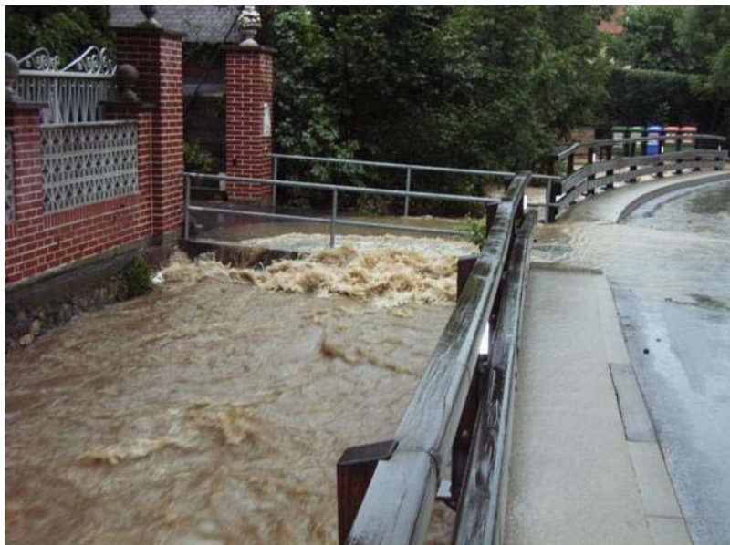
Abbildung 2.4 Thalerbach, Graz, Hochwasserereignisse 2005 ( Hochwasserschutz 2006 IGBK)
