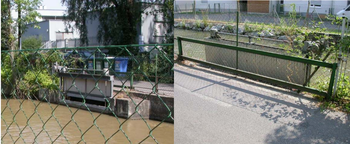
Abbildung 3.35 Wasserentnahme für den Aubach
