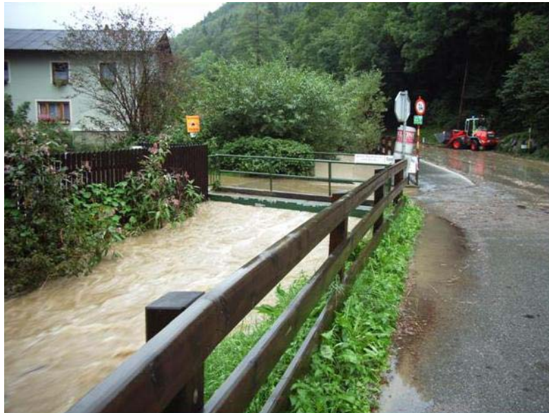
Abbildung 2.6 Thalerbach, Graz, Hochwasserereignisse 2005 ( Hochwasserschutz 2006 IGBK)
