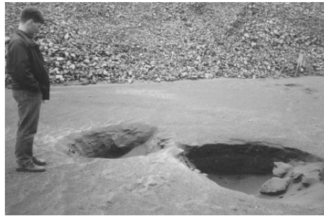
Abb. 1: Erdfall/Erosionstrichter infolge Innerer Erosion
