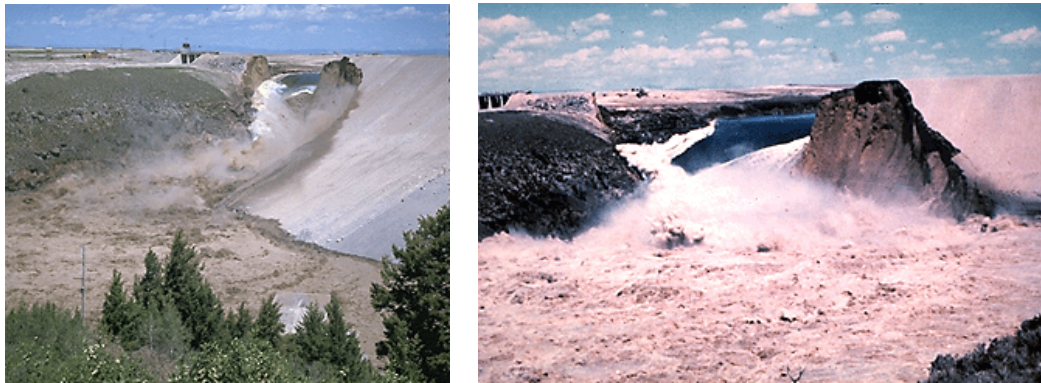
Abb. 2: Zerstörung des Teton Dammes 1976
