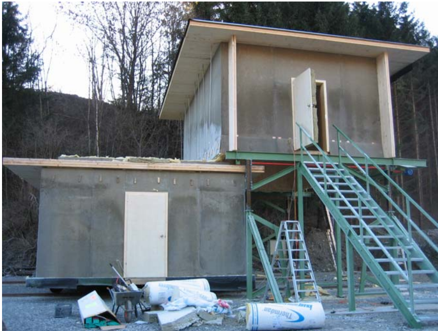
Abbildung 6-1: Prüfstand bei KLH Massivholz GmbH in der Umbausituation
