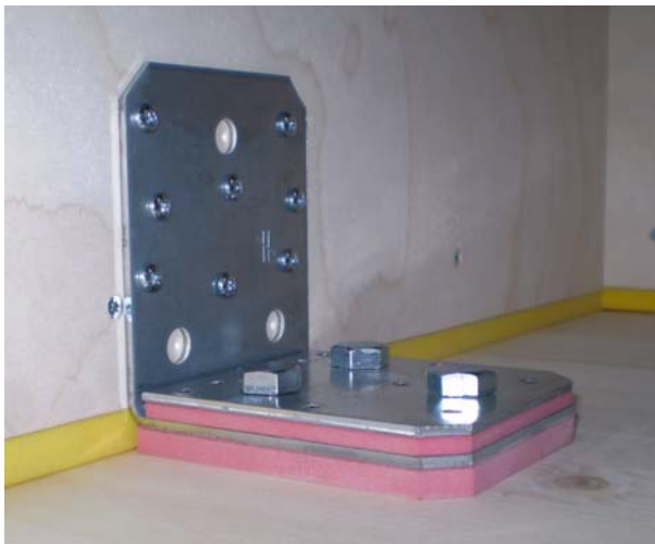
Abbildung 8-20: Schalltechnisch optimierter Winkelverbinder
