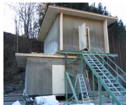
Abbildung 2: Hochflexibler Massivholz-Prüfstand, auf Schienen gelagert.
