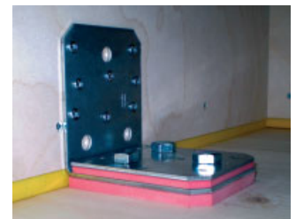
Bild 6. Schalltechnisch optimierter Winkelverbinder Fig. 6. Acoustically optimized connector
