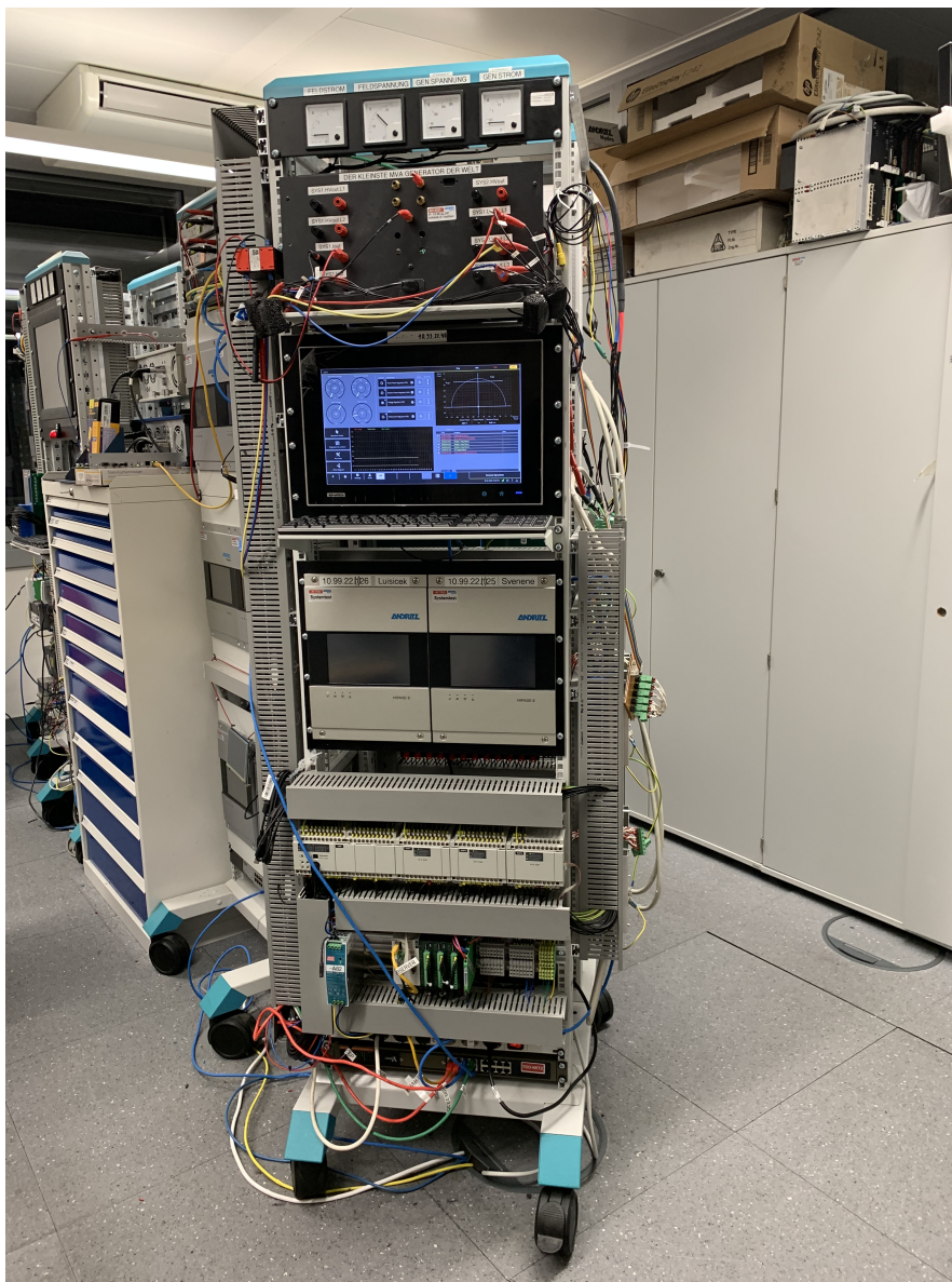
Abbildung B.1: Mobiler Aufbau der gesamten Testumgebung
