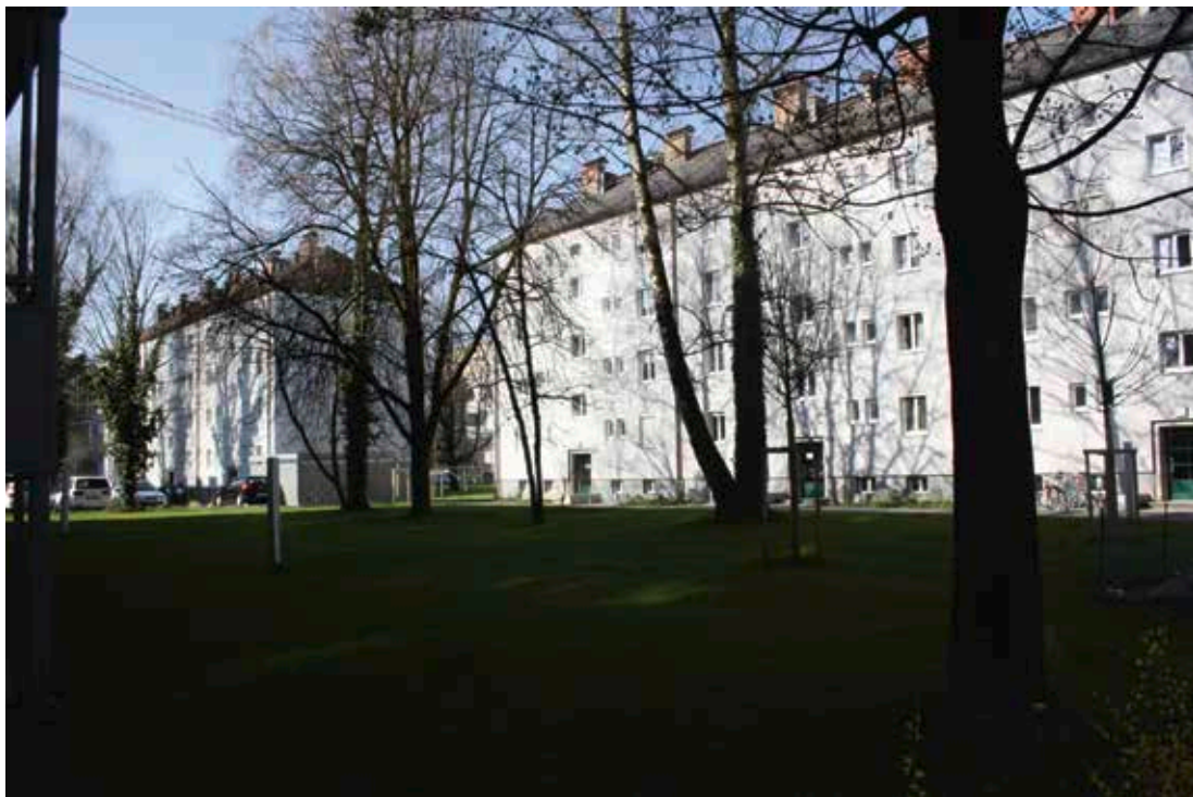
Abbildung 55 Wohnbau Strubergassensiedlung nach der Renovierung 2010–2015 Eigene Quelle
