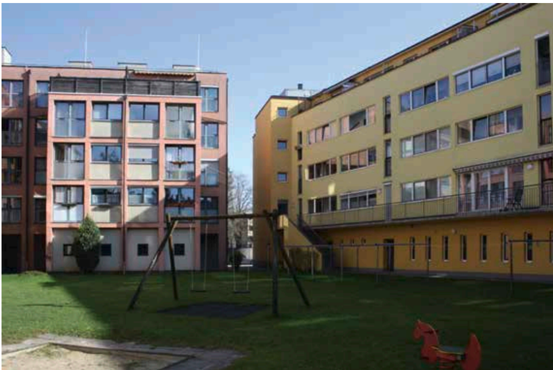
Abbildung 59 Hans-Sachs-Hof und Forellenweg Eigene Quelle
