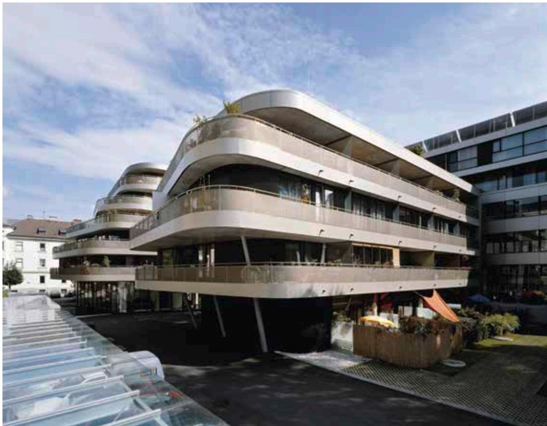
Abbildung 65 @fallnhauser Quelle: HALLE 1
