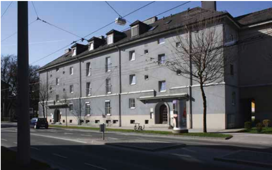
Abbildung 50 Scherzhäuserfeldsiedlung nach der Renovierung und Aufstockung Eigene Quelle
