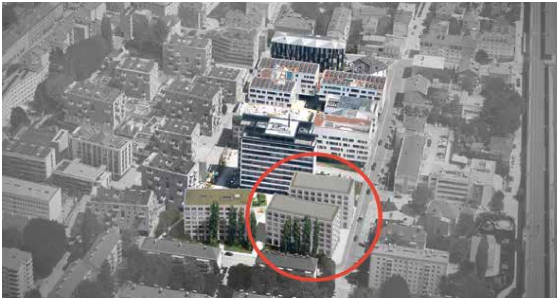
Abbildung 87 Stadtwerk Luftbild – Bauteile Aicher ZT GmbH Quelle: Prisma
