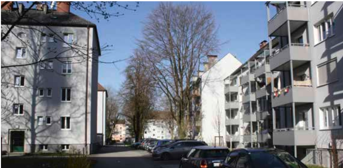
Abbildung 112 Strubergassensiedlung, Altbestand saniert Eigene Quelle
