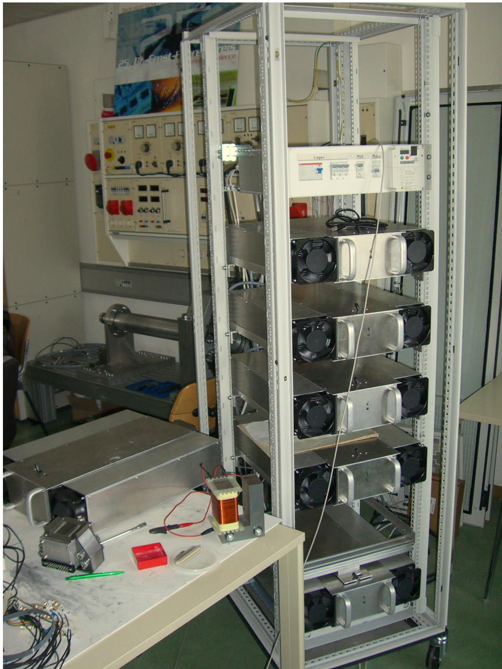
Abbildung 2.4.: Elektronikschaltschrank: HCA-Module 1, 3 bis 6 von unten nach oben, HCA-Modul 2 für Kontrollmessungen am Tisch, AMB-Versuchsstand im Hintergrund
