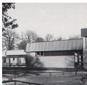
ABB56. ANSICHT ROSENGARD SCHULE
