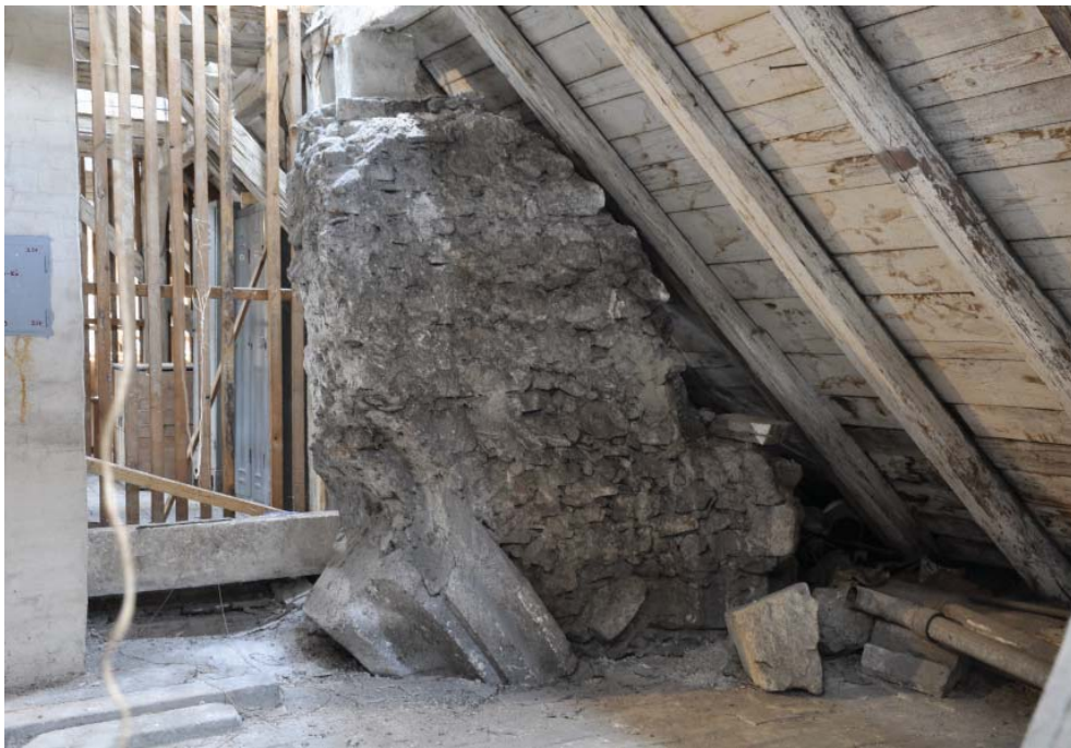
Abb. 1_14: Überrest der ehemaligen Kirchenaußenmauer
