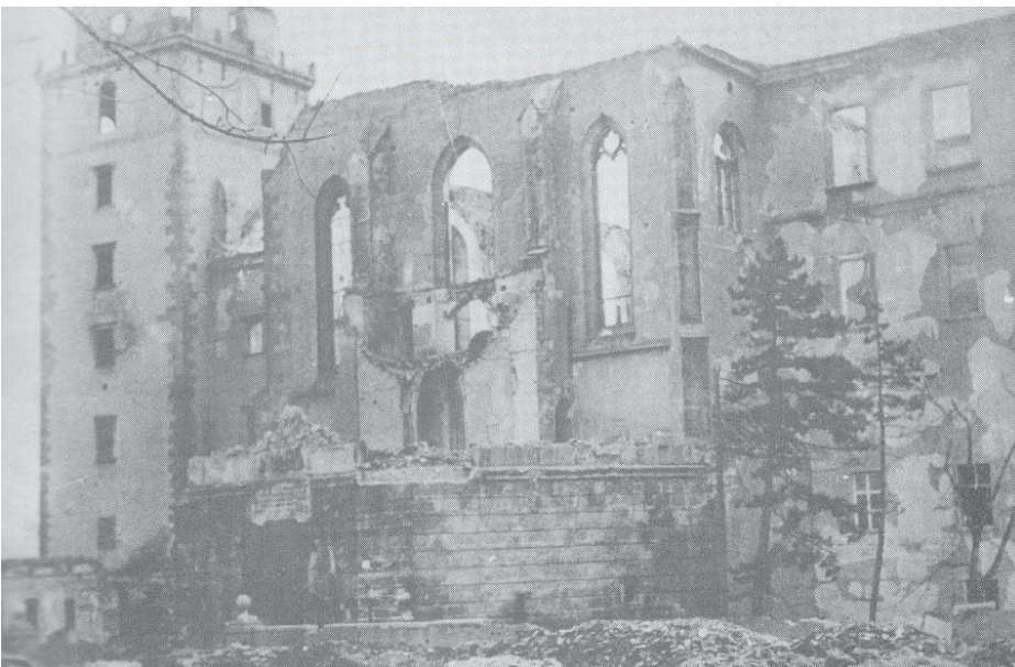
Abb. 10_07: Die stark beschädigte Wiener Neustädter Burg
