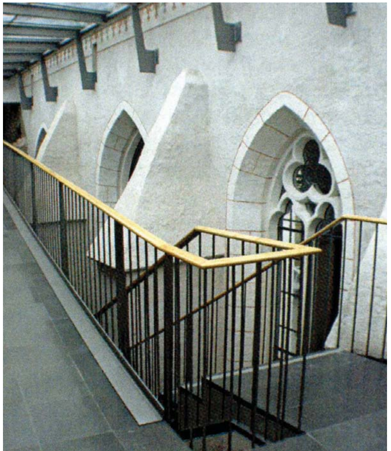
Abb. 21_12: Erschließungstrakt entlang der historischen Kirchenmauer
