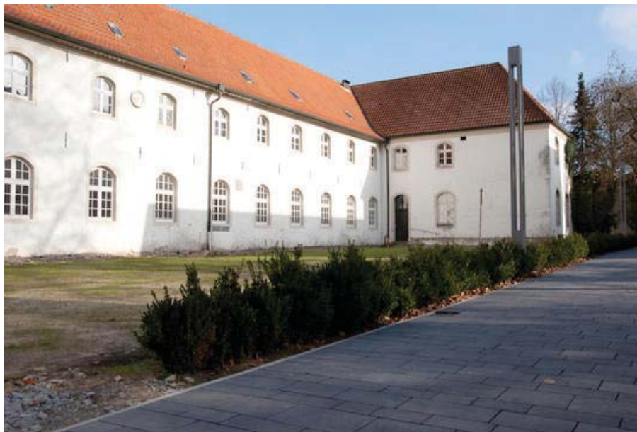
Abb. 21_21: Außenansicht des Traktes der Altenwohnungen
