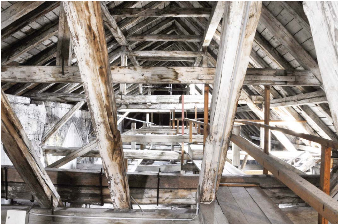
Abb. 25_1: Bestehende Dachkonstruktion über dem Kirchenschiff
