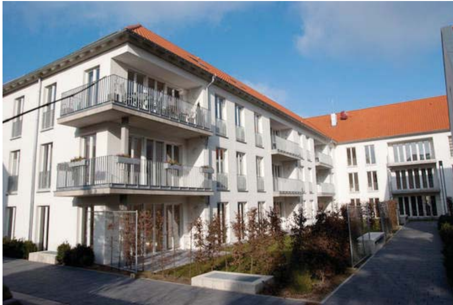
Abb. 21_22: Außenansicht des Neubaus
