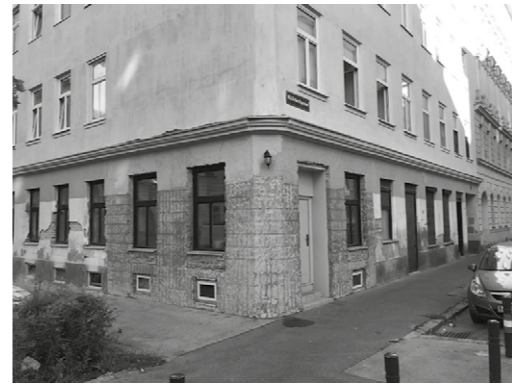
[16] Abgeschlagene Fassade in der Erlachgasse
