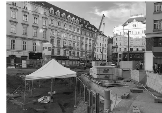
[31] Baustelle Neuer Markt
