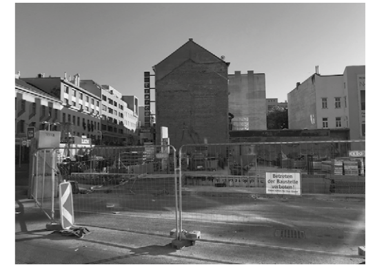
[10] Baustelle Ecke Favoritenstraße | Landgutgasse
