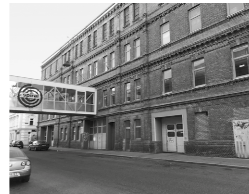
[20] Pernerstorfergasse 62: erhaltenes Industriegebäude
