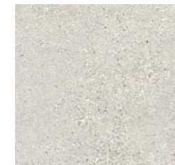
Beton gestockt - örtliches Gestein als Zuschlagstoff
