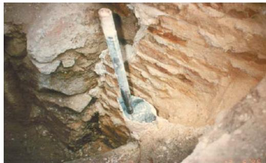
Abbildung 31: Schrägbohrung aus Fundamentnische [2, S. 13]
