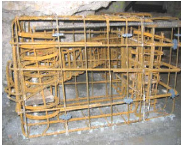
**Abbildung 40:** Bewehrung Pfahlkopf (Druckpfahl) [35]
