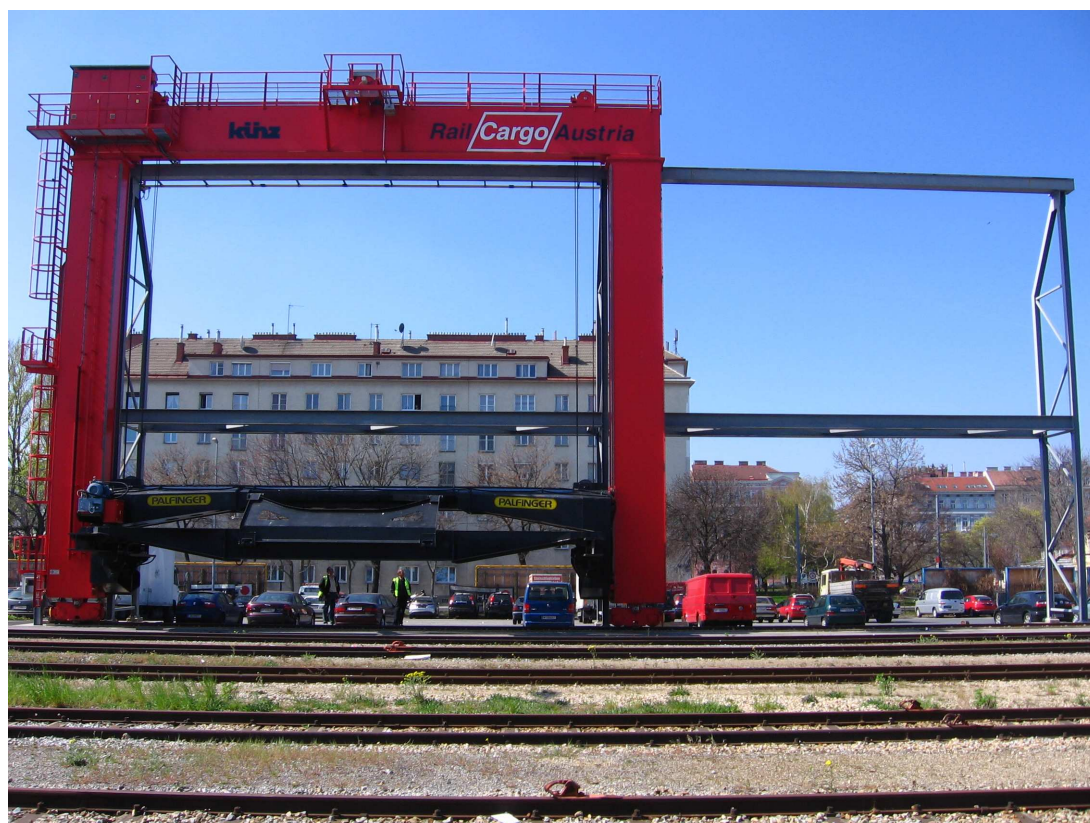
Abb.19: Versuchsanlage des IUT Systems in Terminal Nord-West Bahn Wien (persönliches Foto 6/4.2007)
