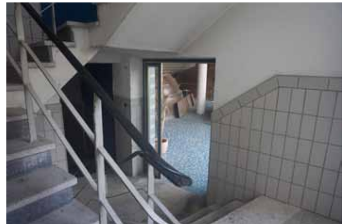
Abb. 255: Übergang zum Sudhaus Erdgeschoss
