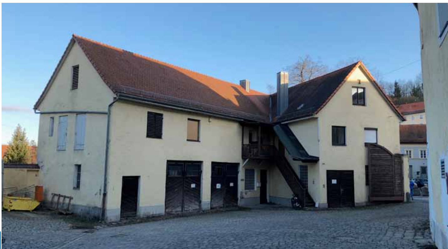
Abb. 276: Werkstattgebäude von Nordwesten
