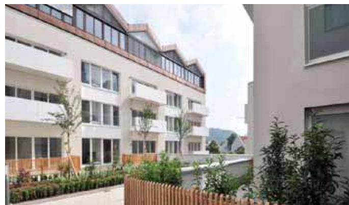
Abb. 80: Areal 2, Rückseite der ehem. Flaschenfüllerei
