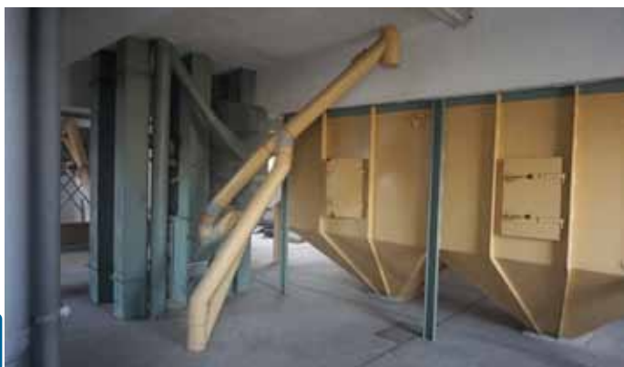
Abb. 249: Silo Kopfbau 1.OG
