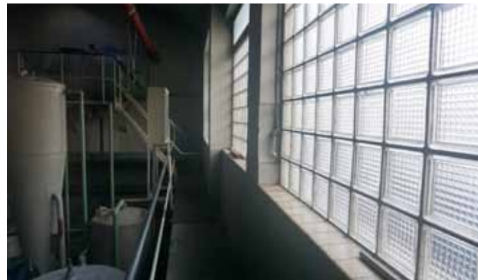
Abb. 234: Kesselhaus Fensterfront Süden
