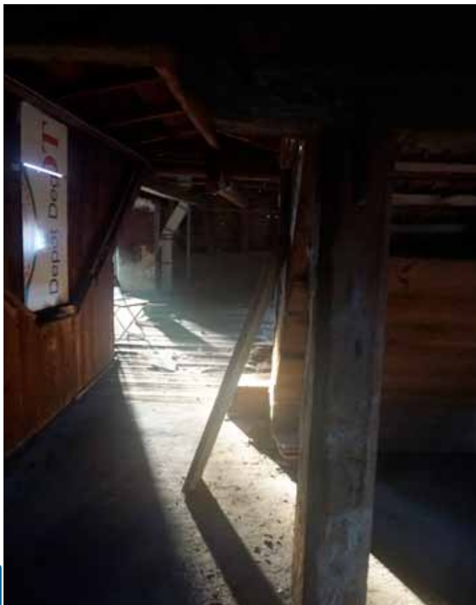
Abb. 200: Dachgeschoss Haus I
