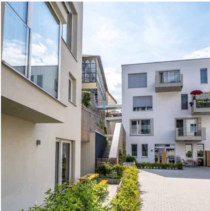
Abb. 77: Areal 2, „Ringbebauung“ mit Glaspalast
