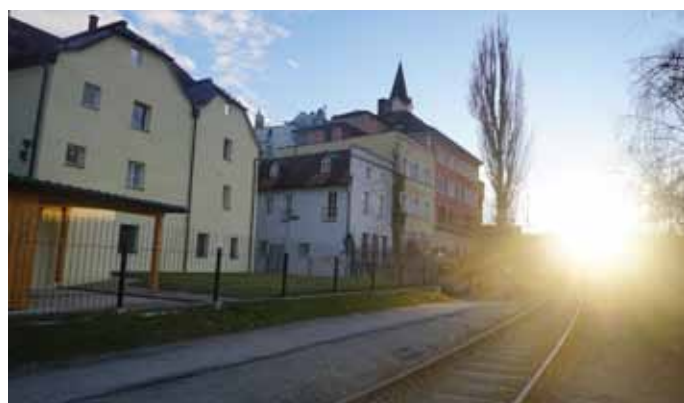
Abb. 100: Innstadtbahnhofweg zirka auf Höhe Mitte Löwengrube
