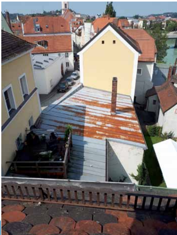
Abb. 205: Ausblick von der Darre auf das Dach der Löwengrube 29
