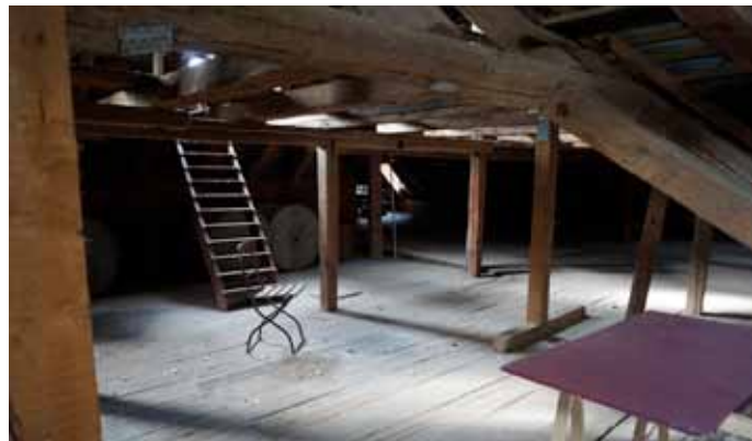
Abb. 199: Dachgeschoss Haus I
