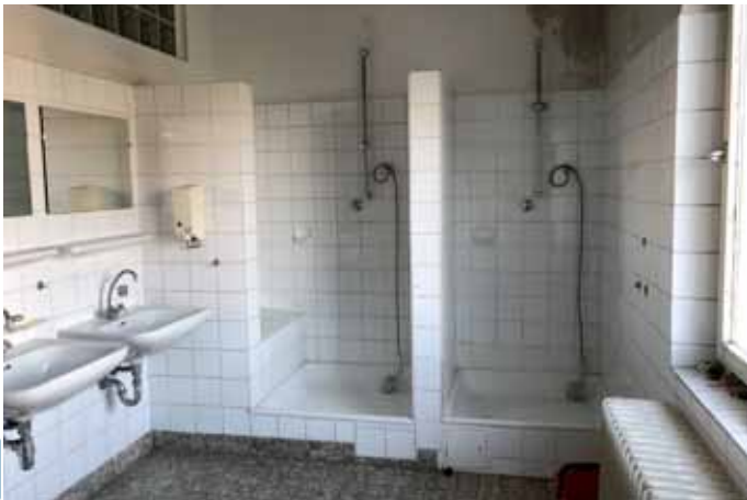
Abb. 277: Sanitärräume im OG des Werkstattgebäudes
