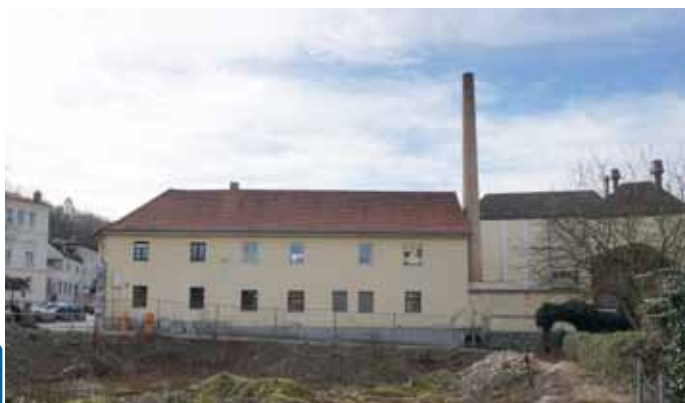
Abb. 260: Außenansicht Werkstattgebäude vom Paradiesgarten
