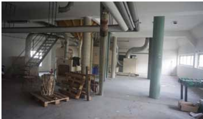
Abb. 248: Silo Kopfbau 2.OG
