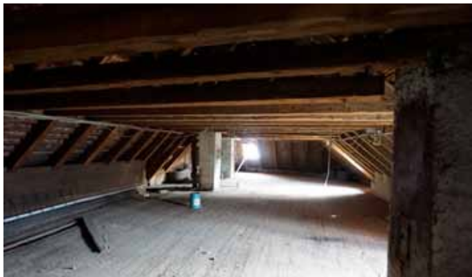
Abb. 198: Dachgeschoss Haus I
