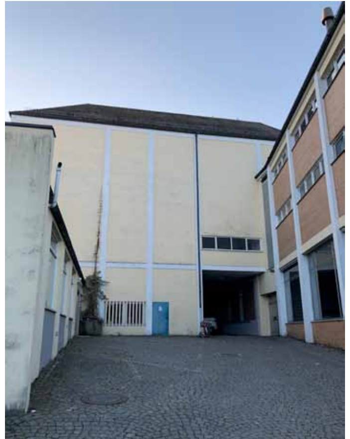
Abb. 247: Silo von außen
