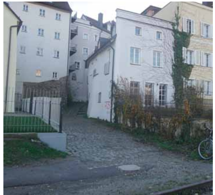
Abb. 135: Eintritt in die Schiffmühlgasse am Innstadtbahnhofweg
