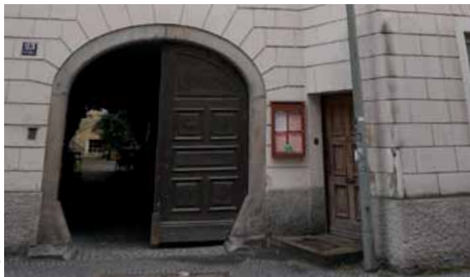
Abb. 196: Holztor, Zugang Haus II
