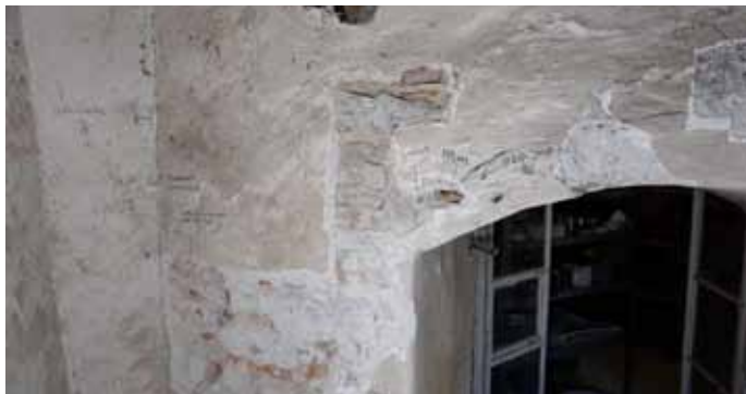
Abb. 217: Befundung, Teil der ehem. Stadtmauer, Darre, EG
