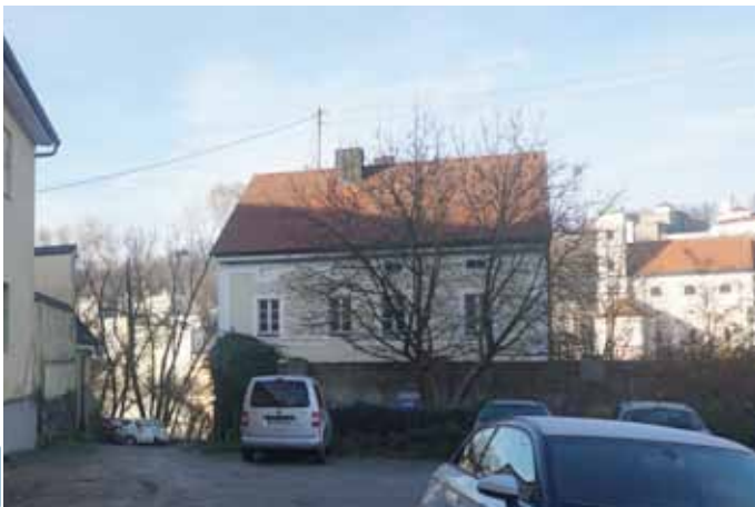
Abb. 268: Kapuzinerstraße 1 von Süden
