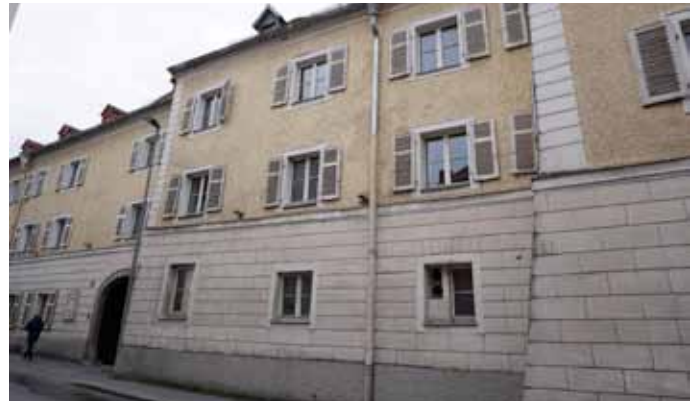
Abb. 189: Fassade Haus II von Südosten
