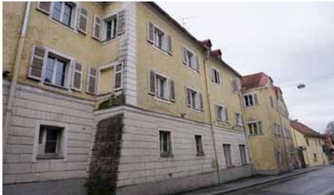
Abb. 187: Fassade Haus II von Südwesten
