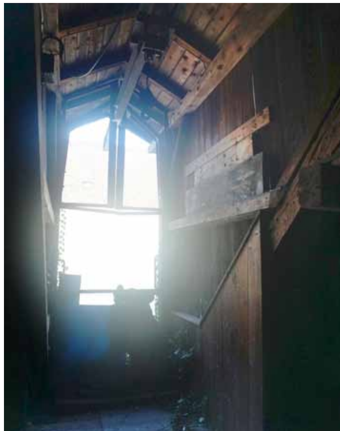
Abb. 201: Dachgaube zum Innenhof, Dachgeschoss Haus I
