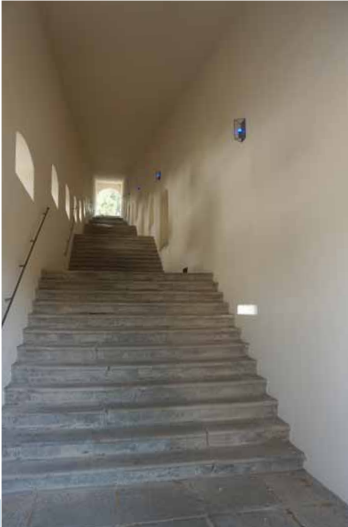
Abb. 54: Wallfahrts-Stiege Mariahilf nach Sanierung 2018
