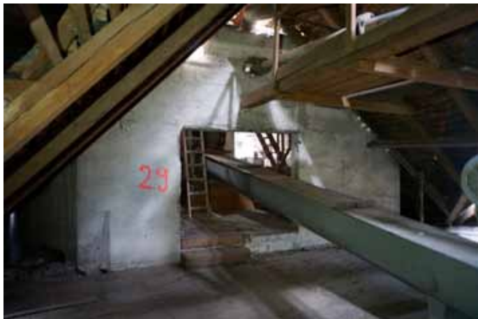
Abb. 220: Zugang Darre vom Verbindungsbau
