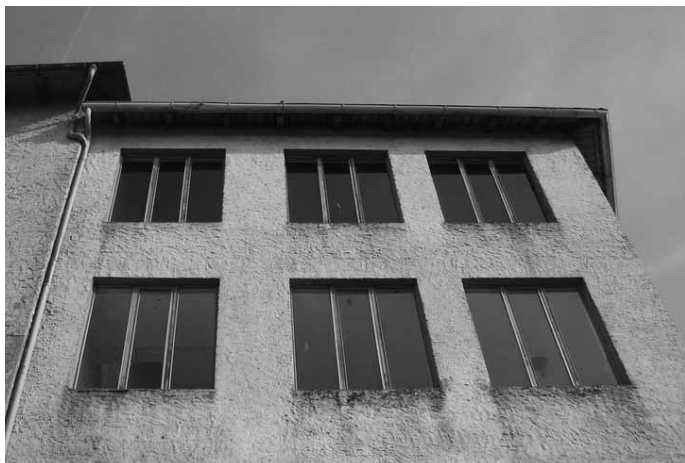
Abb. 181: Fassade Lechnerbräu vorher
