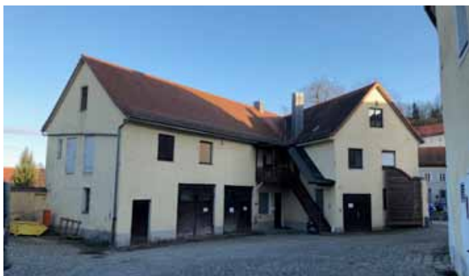
Abb. 259: Außenansicht Werkstattgebäude vom Hof
