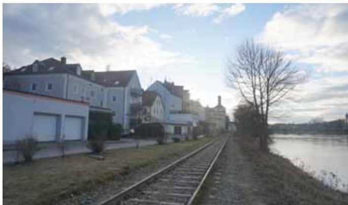
Abb. 95: westlich der Kreuzung Innstadtbahnhofweg
