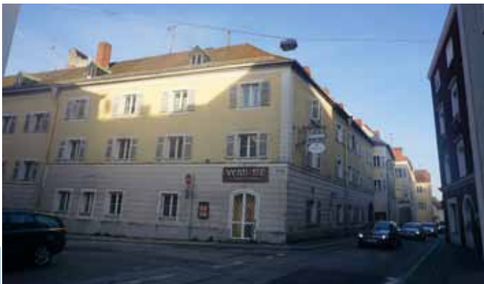
Abb. 191: Schmiedgasse 23 von Südwesten
