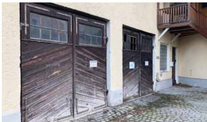
Abb. 258: Außenansicht Werkstattgebäude Tore
