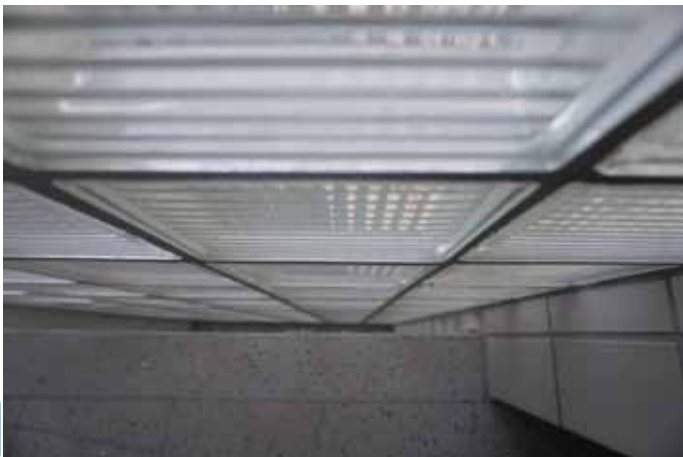
Abb. 252: Lichtband Glasbausteine von innen
