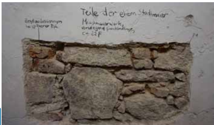
Abb. 209: Befundung, Teil d. ehem. Stadtmauer, früher Anbau, EG
