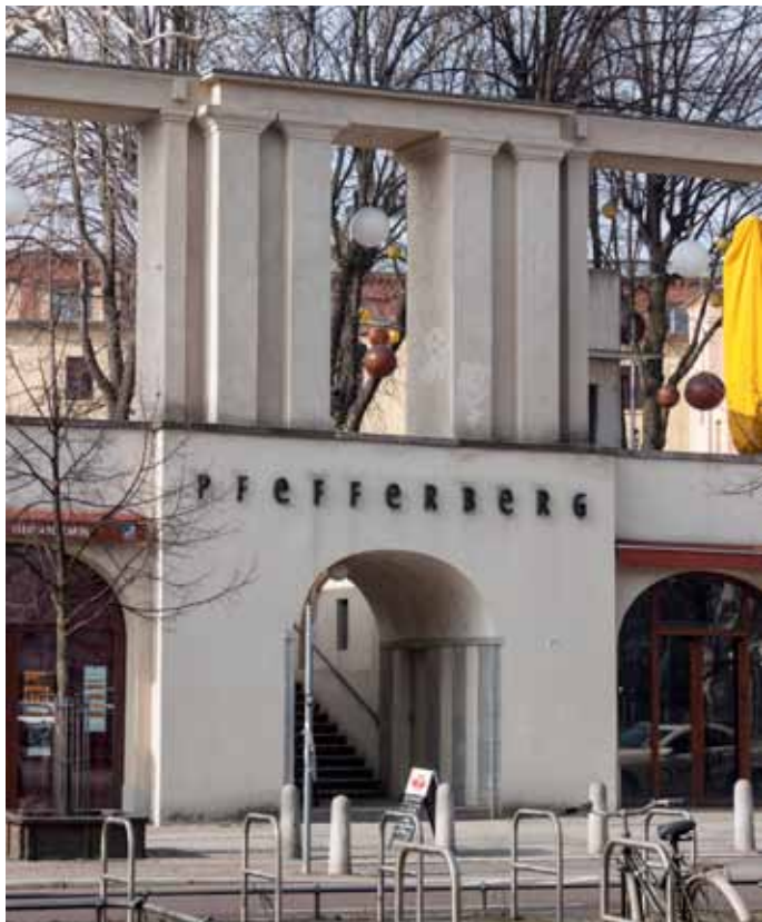
Abb. 160: Eingangsportal zum Pfefferberg
