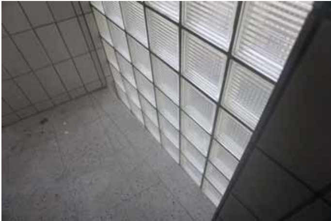
Abb. 251: Lichtband Glasbausteine von innen
