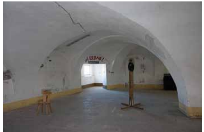
Abb. 211: früher Anbau 1.OG, ehem. Teil d. Stadtmauer
