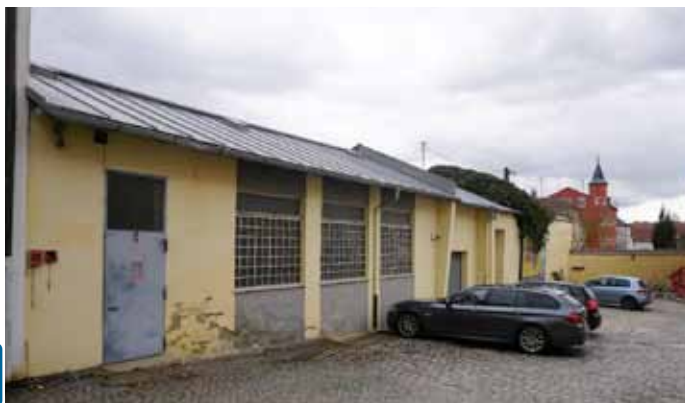
Abb. 233: Kesselhaus Fensterfront Süden
