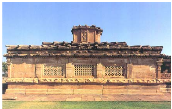
Abb. 110: Ansicht S Lāḍ Khān-Tempel/Aihole
