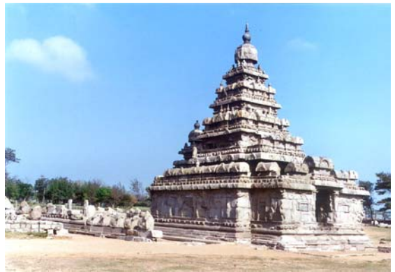
Abb. 204: Ansicht SO Tempel/Mahābalipuram
