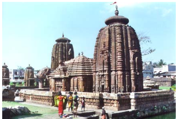
Abb. 142: Ansicht SO Mukteśvara-Tempel/Bhubanesvara
