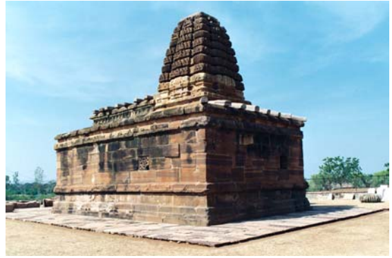
Abb. 122: Ansicht SW Huchchimalliguḍi-Tempel/ Aihole
