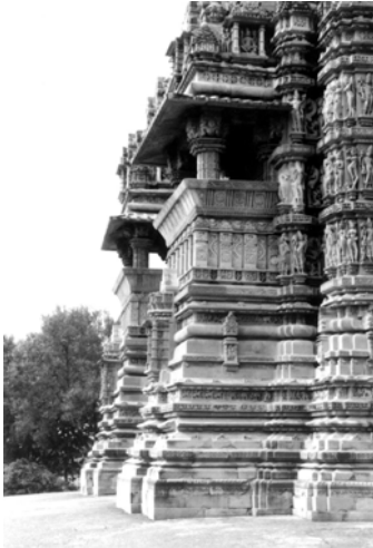
Abb. 196: Ansicht Veranden Kaṇḍarīya-Mahādeva-Tempel
