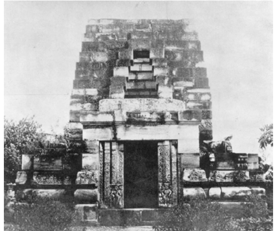
Abb. 129: Ansicht Śatṛughneśvara-Tempel/ Bhubanesvara
