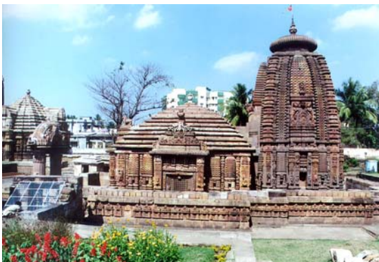
Abb. 141: Ansicht S Mukteśvara-Tempel/Bhubanesvara
