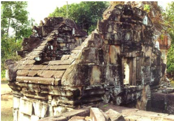
Abb. 292: Ansicht Dach Adikulae Bakong/Rolous
