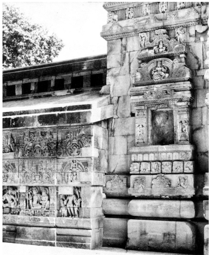
Abb. 136: Anschlussstelle śikhara-jagamohan Paraśurāmeśvara-Tempel/Bhubanesvara
