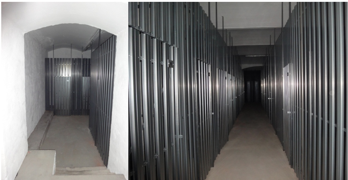
Souterrainflächen / Self Storage nach Adaptierung
