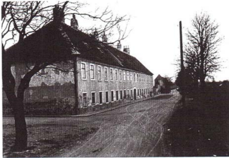
Abb 21_Südwestansicht Meierhof Schloss Neugebäude, ca. 1910
