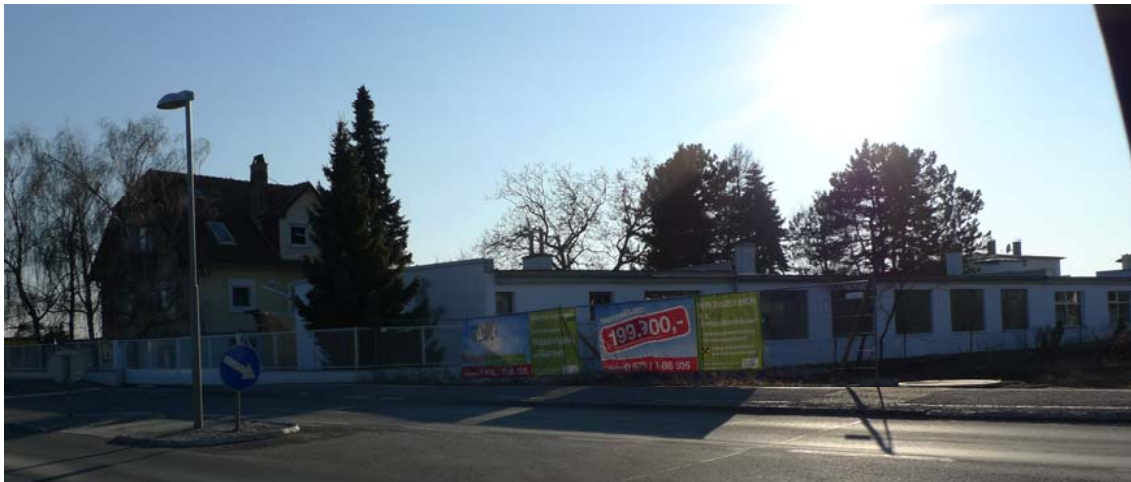
Abb. 8: Wiener Neustädterstraße 86, 2540 Bad Vöslau, 2011, Blick auf das Wohnhaus und den Werkstättentrakt
