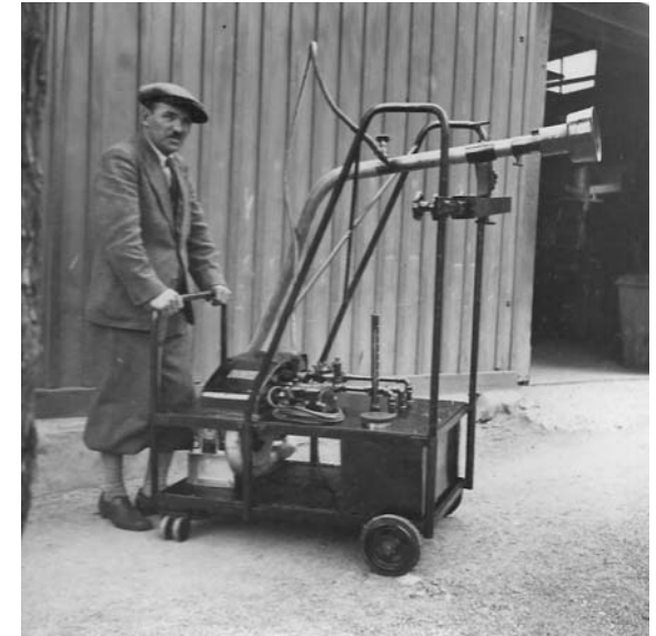
Abb. 39: Franz Krenn mit einer mobilen Rohölfeuerung vor dem neuen Schuppen
