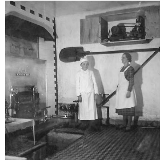
Abb. 57: technische Einrichtung für die Ölfuerung, Luftkompressor im Hängeschrank
