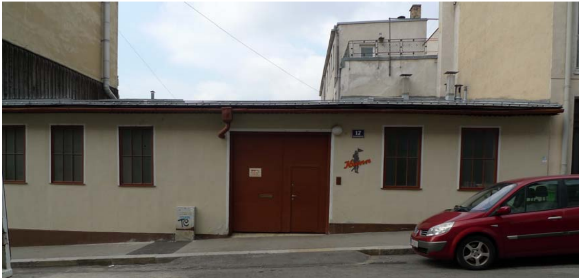
Abb. 6: Gusenleithnergasse 17, 1140 Wien, 2011, Haupteingang mit zweistöckigem Wohntrakt im Hintergrund
