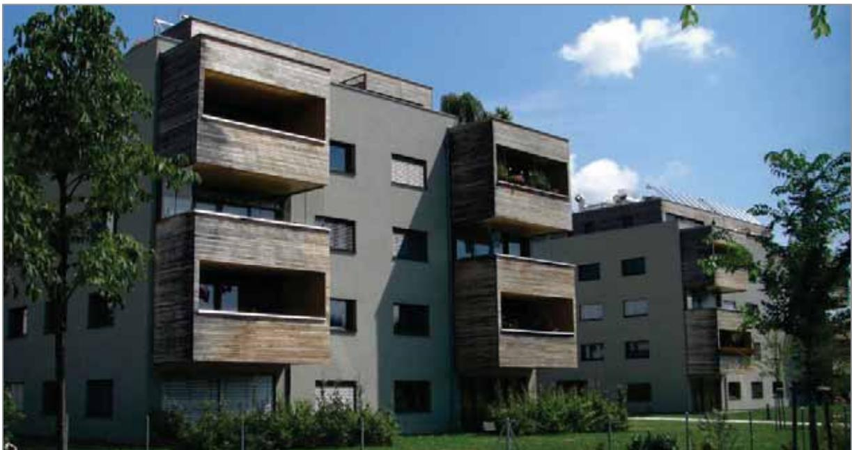
Abbildung 9, Die Balkon-/ Loggienkonstruktionen wurden als vorgefertigte Boxen an das Bauwerk gehängt
