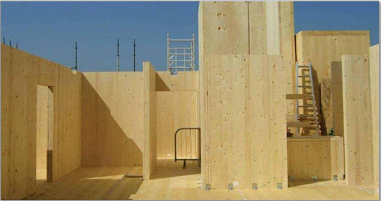
Abbildung 21, Montage der "KLH"-Platten
