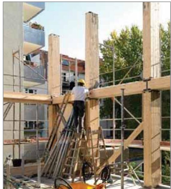
Abbildung 18, Montage der Brettschichtholzstützen
