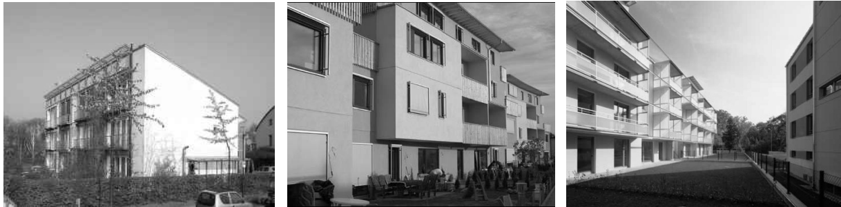
Abbildung 1: Passivwohnhaus, Darmstadt Kranichstein, H. Bott, K. Ridder, H. Westermeyer
