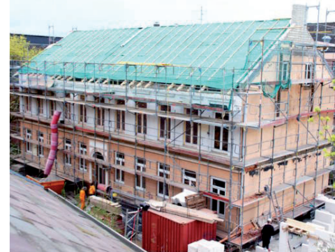
Abb. 13 Eines der Gebäude von Greves Garten während der Renovierung
