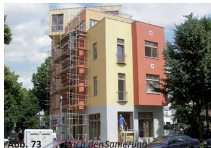
Abb. 73 Nach der Sanierung
