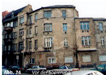
Abb. 74 Vor der Sanierung
