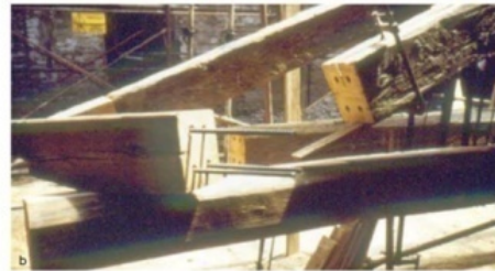
Figura 10 Protesi lignee su testate di capriate, intervento in opera (a) o a terra (b)
