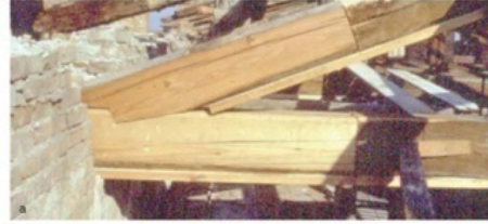
Figura 28 Le tavole laterali e i traversini devono rimanere in opera per almeno 24 ore
