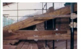
da l'intervento finito
