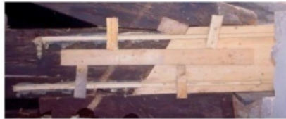
Figura 28 Le tavole laterali e i traversini devono rimanere in opera per almeno 24 ore
