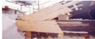
Figura 31 In questo caso, oltre all'astinità della catena, è stata ricostruita anche quella del puntone con la medesima laurice
