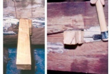
Figura 50 Messa in opera dei cunei di chiave
