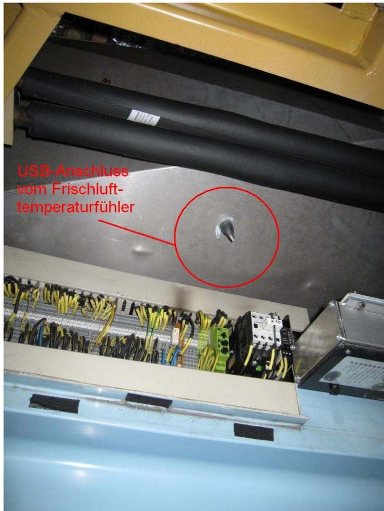
Abb. 18 Frischlufttemperaturfühler über dem WC
