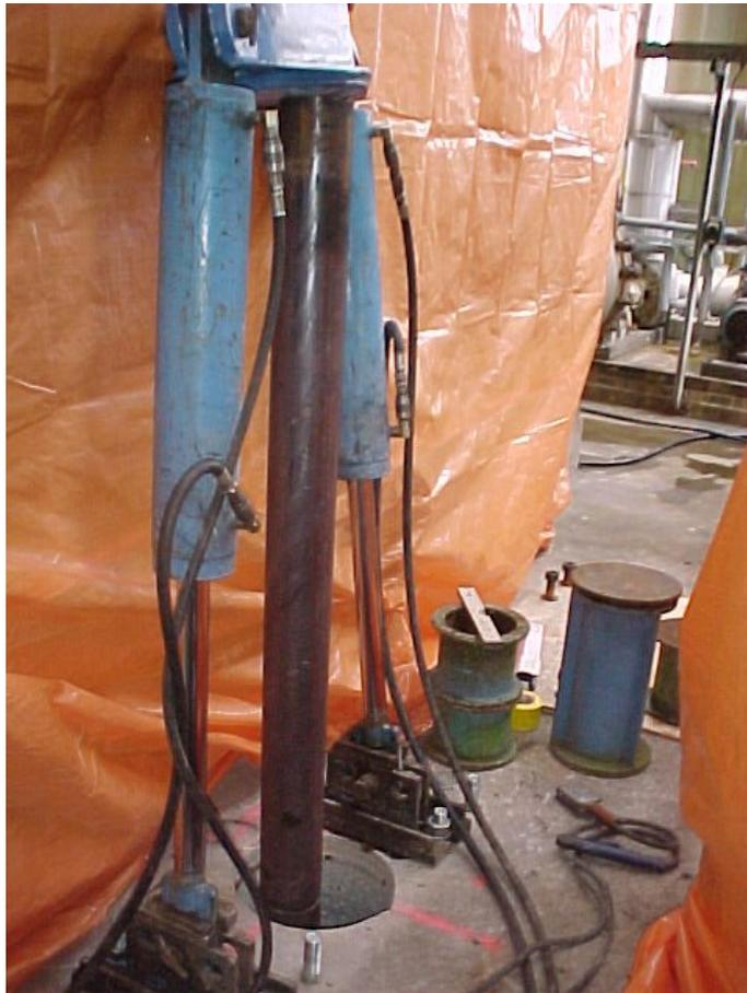
Abbildung 16: Verankerung der Presse an der Sohle [30]
