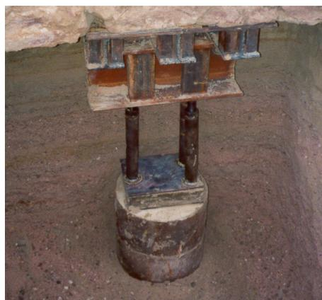
Abbildung 49: Lastverteilungsträger der Firma Erka-Pfahl [28]
