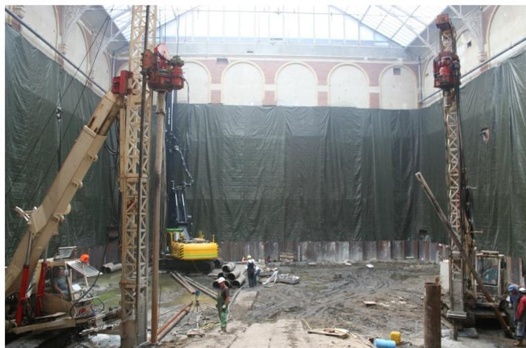
Abbildung 12: Stahlverdrängungspfähle in Holland [30]
