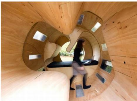
Das **Final Wooden House** von Sou Fujimoto Architects ist ein Ferienhaus inmitten eines Waldes in Japan. Es ist lediglich aus 350mm dicken Holzträgern gebaut. Der Architekt wollte eine primitive und gleichzeitig funktionale und minimale Raumnutzung herstellen. Den einzigartigen Raum schuf er, indem er die 350mm dicken Elemente zu stapeln begann und so verschiedenste nutzbare Räume schuf.
