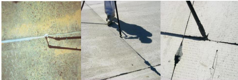
Abbildung 19: Ausbessern von Fugenfüllungen 19
