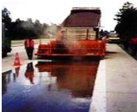
Abbildung 39: Reparatur von Betonfahrbahnplatten mit sofortiger Verkehrsfreigabe 19
