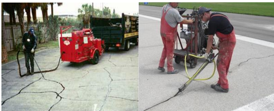
Abbildung 22: Verfüllen von Rissen
