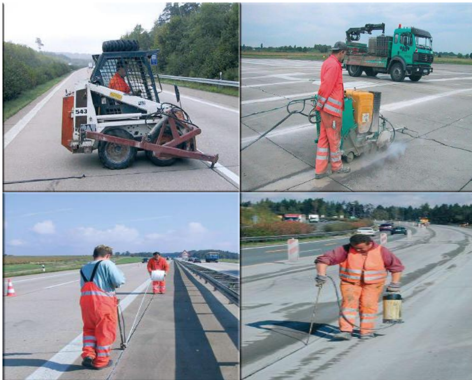
Abbildung 20: Sanieren von Fugen 19
