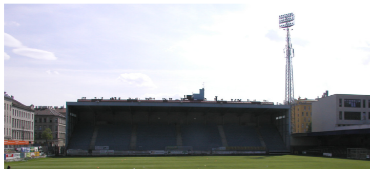
2.81 Sitzplatztribüne süd (Blaue Tribüne), fertiggestellt 1984
