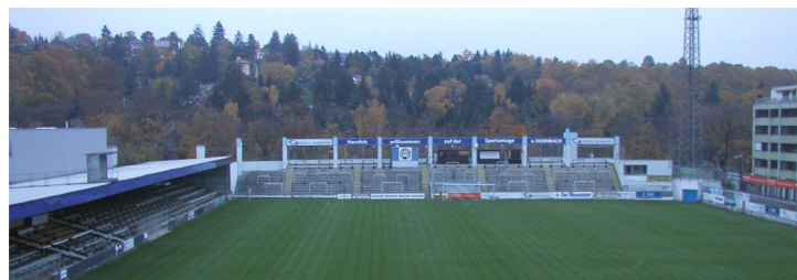
2.80 Stehplatztribüne Alszeile (Friedhofstribüne), fertiggestellt 1981
