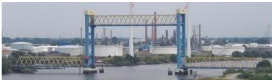
Abbildung 3: Kattwykbrücke mit geöffnetem Tragwerk<sup>17</sup>
