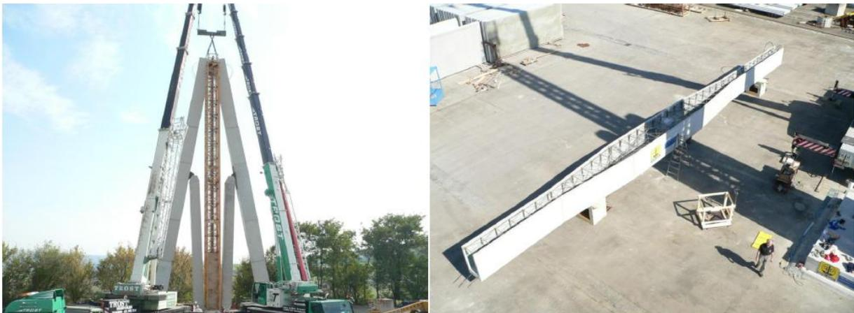
Abbildung 10: Errichtung der Klappbrücke Gars am Kamp<sup>18</sup>
