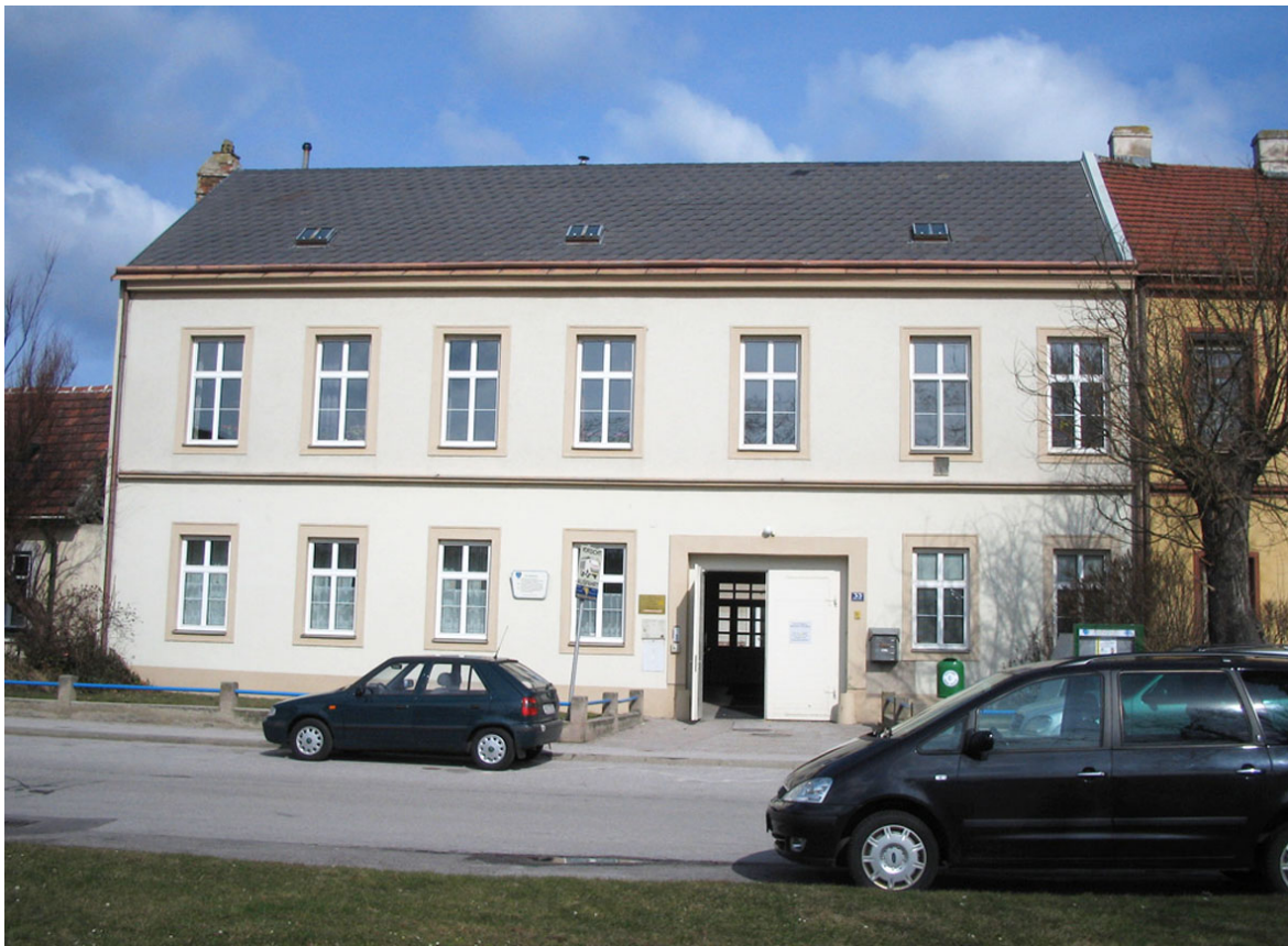
Abb. 49: Alte Volksschule, Frontfassade (Juni 2009)
