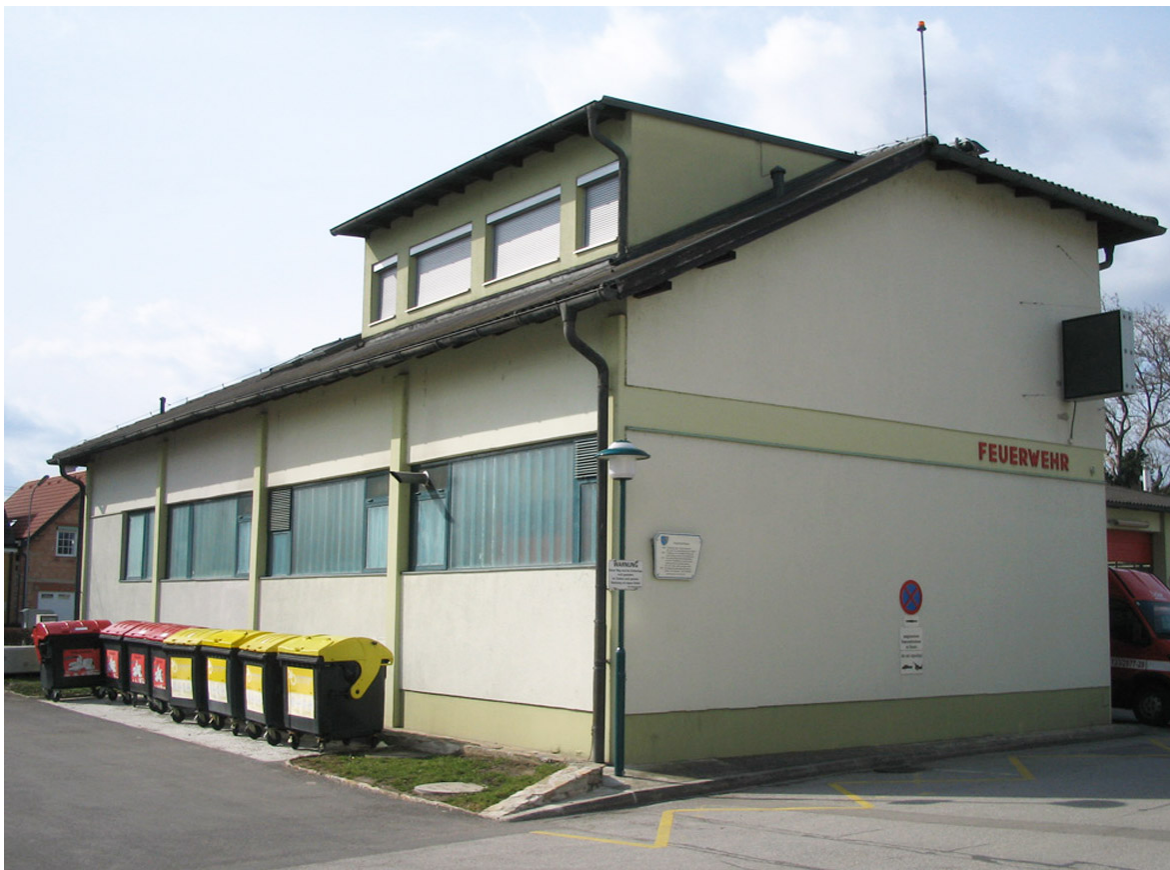
Abb. 53: Alte Feuerwehr, Zubau von 1982 (Juni 2009)
