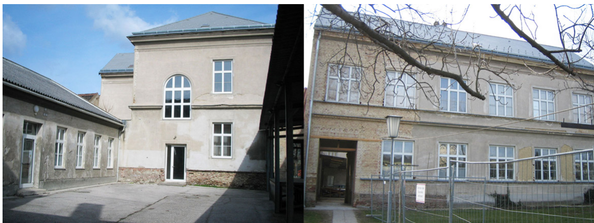
Abb. 50: Alte Volksschule, Nordtrakt mit Seitentrakt, Rückseite mit Durchgang (Juni 2009)
