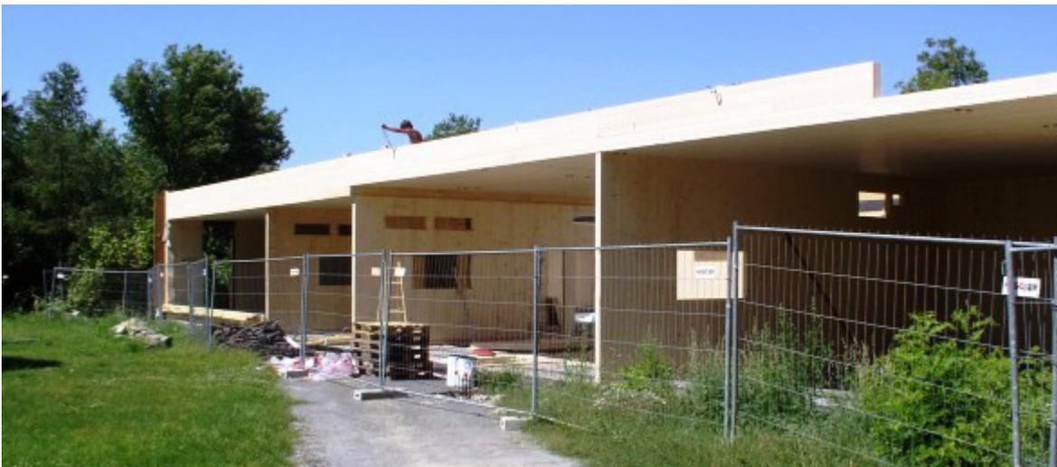
Der eingeschossige, nicht unterkellerte Baukörper wurde zum Großteil aus vorgefertigten Holzelementen errichtet. Basis ist eine Fundamentplatte aus Stahlbeton, auf welche die tragenden Wände und Decken aus Brettsper Holzplatten gebaut wurden.
