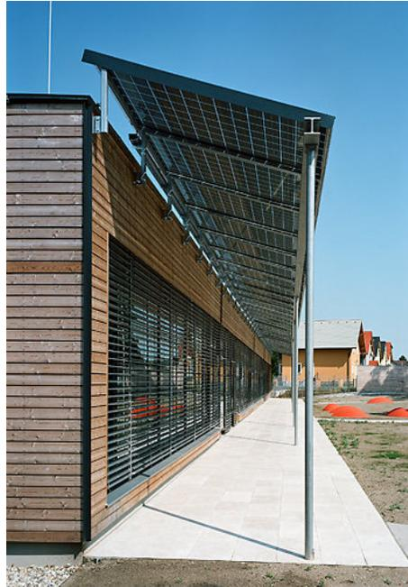
Abb. 16: Vordach aus Photovoltaik-Modulen
