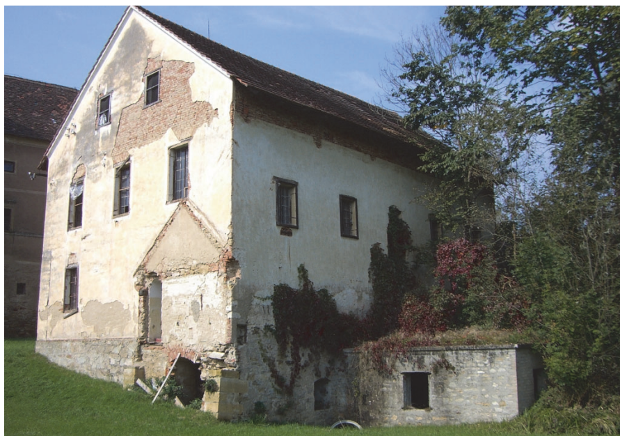
Abbildung 9 _ Südostansicht der Mühle
