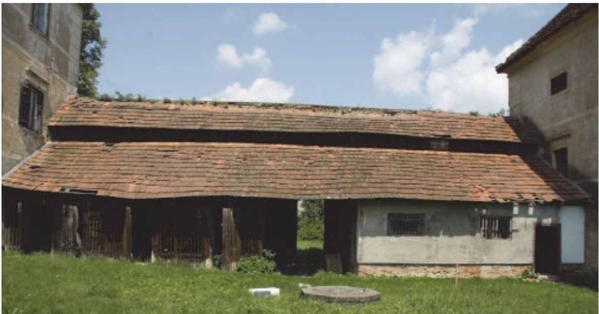
Abbildung 13 _ Innenseite der Nordmauer von Schloss Klaffenau mit vorgelagertem Schuppen
