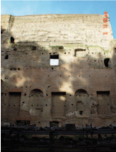
Abb. 6/5 Nicht entzerrtes Foto der Westwand des Atriums mit stürzenden Kanten.
