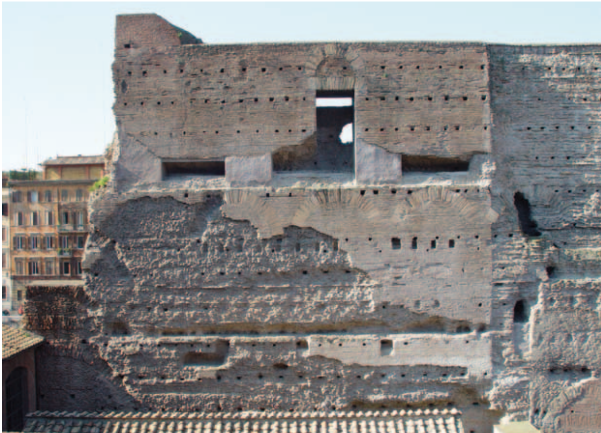
Abb. 7/35 Das nicht vermessene Teilstück der Mittelwand zwischen Atrium und Westsaal. An den höher gelegenen Bereichen ist noch die originale Mauerschale erhalten.
