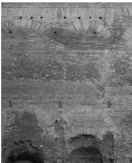
Abb. 7/55 Firstlinie des Daches an der Südwand.
