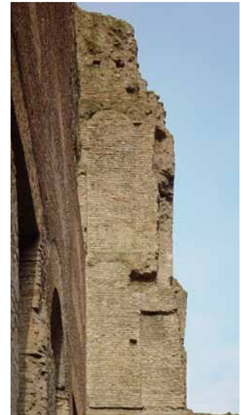
Abb. 7/14 Die linke Nische an der Nordwand des Atriums ohne Entlastungsbogen.
