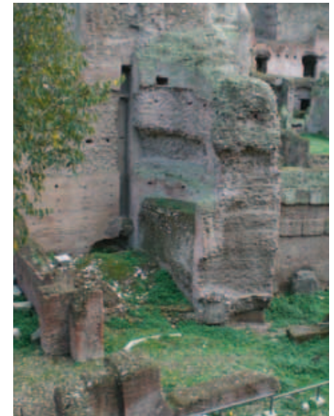
Abb. 3/22 Im nördlichen Portikus – Blick auf den Zugang zur Rampe.
