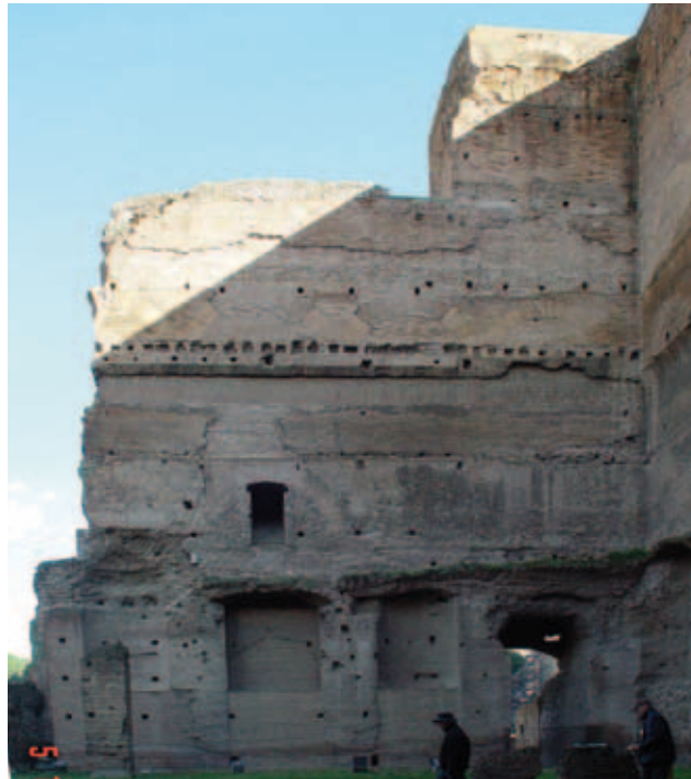
Abb. 3/5 Die Südwand mit den durchbrochenen Nischen.
