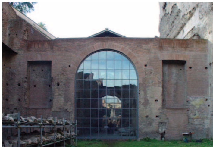
Abb. 3/9 Die Westwand. An der Wandfläche fällt besonders die charakteristische Struktur der oberen Zone auf.
