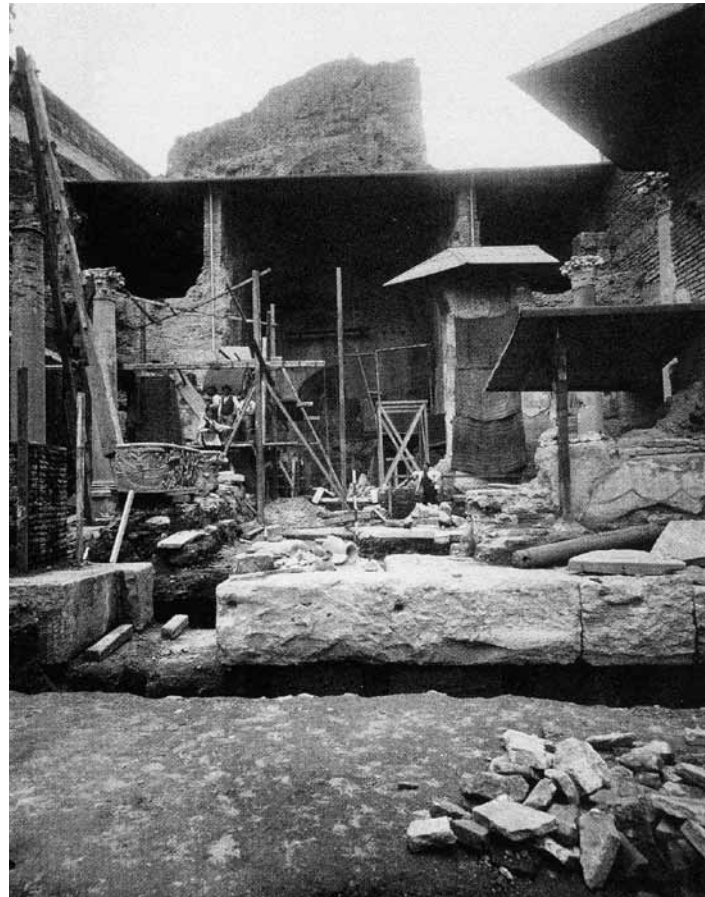
Abb. 4/48 Provisorische Abdeckungen des freigelegten Presbyteriums und der Fresken in der spätantiken Kirche.
