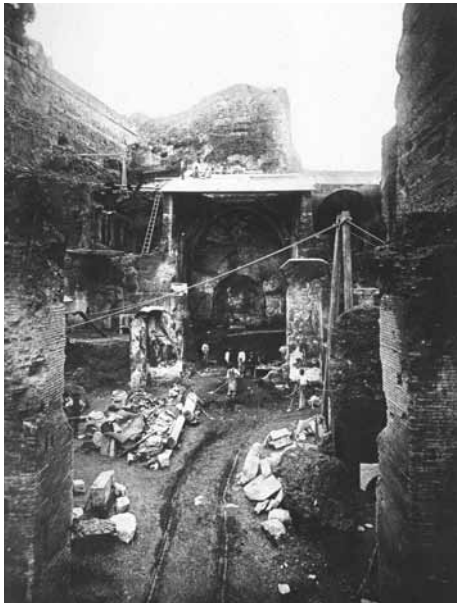
Abb. 5/10 Ausgrabungsarbeiten im Mittelschiff der Kirche.
