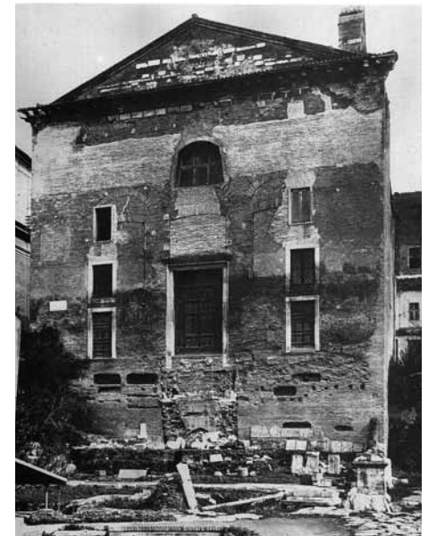
Abb. 1/12 Das in eine Kirche transformierte Senatsgebäude während der Freilegung.
