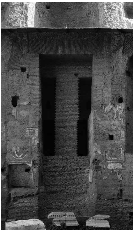
Abb. 4/24 Die zentrale Nische an der Ostwand, die im Mittelalter zu einer Apsis transformiert wurde.
