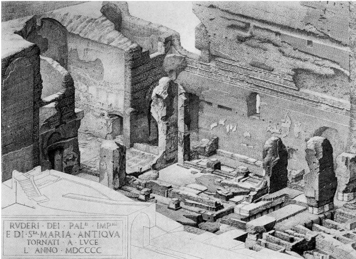
Abb. 5/24 Axonometrische Darstellung der Überreste der Kirche von Antonio Petrignani nach der Freilegung. Im Vordergrund angeschnitten die Rampe.
