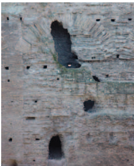
Abb. 7/27 Anlauf des Bogens in der Westwand, der von der heute zerstörten Südwand überlagert wurde.
