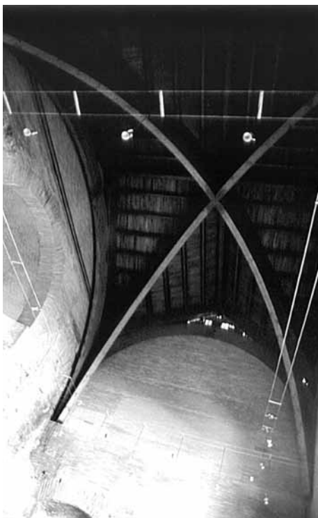
Abb. 4/58 Die Überdachung des Oratoriums.
