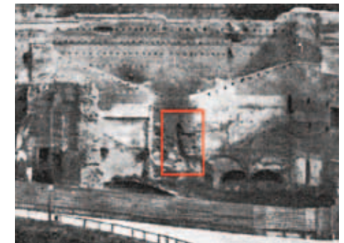
Abb. 7/61 Durchgang mit Stiege unterhalb eines Entlastungsbogens an der Nordwand.
