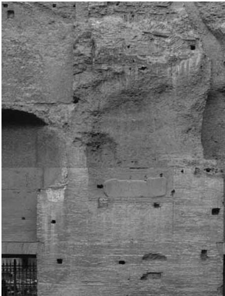
Abb. 7/41 Die mittlere Nische in der Ostwand.
