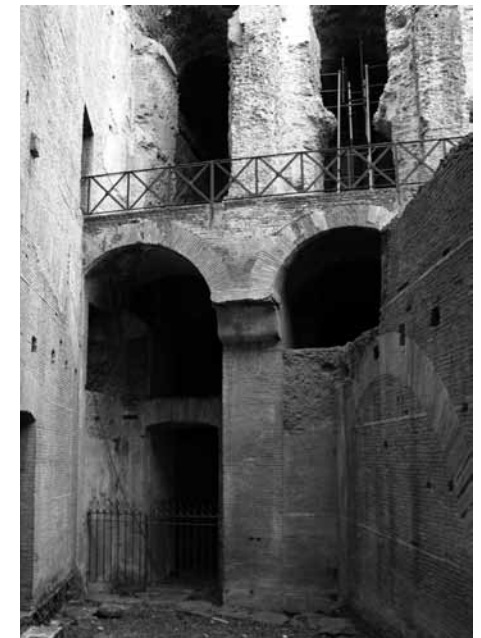
Abb. 2/9 Foto des gleichen Bereiches (entspricht dem 4. und 5. Bogen in der Schnittzeichnung).
