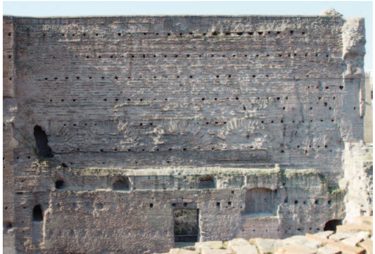
Abb. 7/26 Konstruktive Wandanalyse der Bauaufnahme 2003 mit Markierung der Entlastungsbögen an der Westwand des Atriums.
