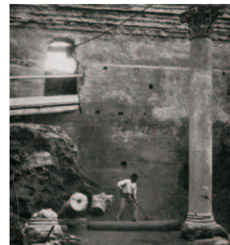
Abb. 7/1 Ausbrüche in und unterhalb der Nischen im Westsaal.
