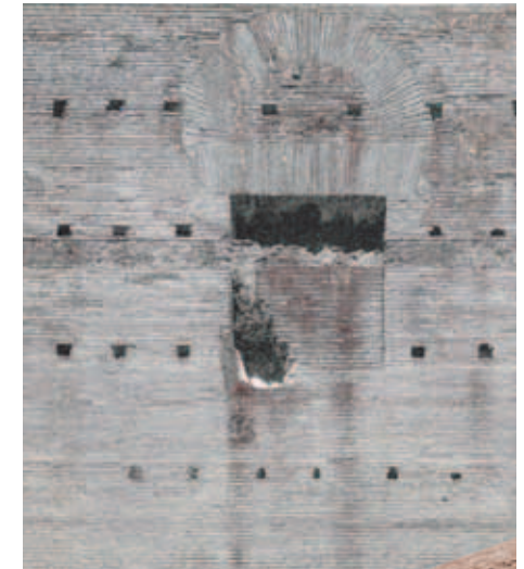
Abb. 7/69 Abdrücke der Rückflächen gewölbter Kammern an der Ostwand.
