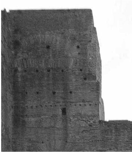
Abb. 7/77 Wandscheibe mit vermauerter Öffnung an der Südwand.
