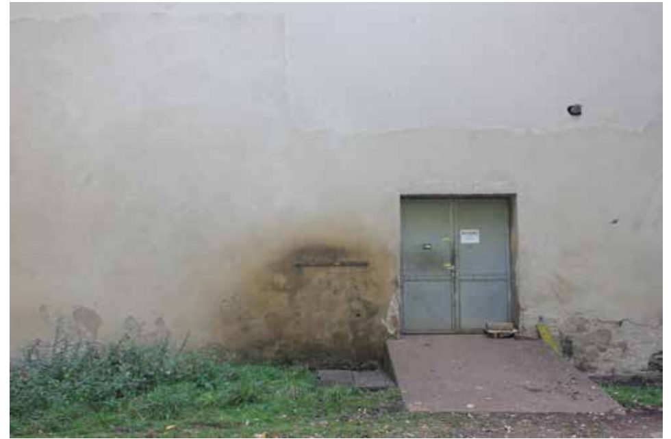
Abb.61: Nordfassade mit Zugang zum Fördermaschinenhaus
