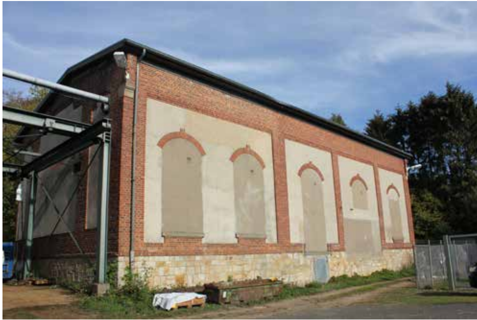
Abb.60: Südfassade des Fördermaschinenhauses
