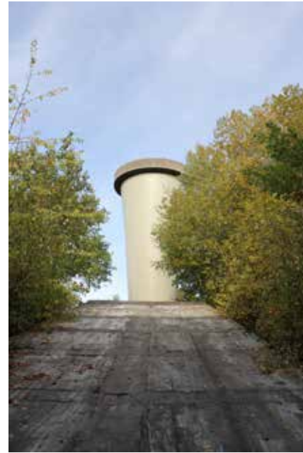
Abb. 66: Blick auf Dach des Wetterkanals und Diffusor des Hauptlüftergebäudes
