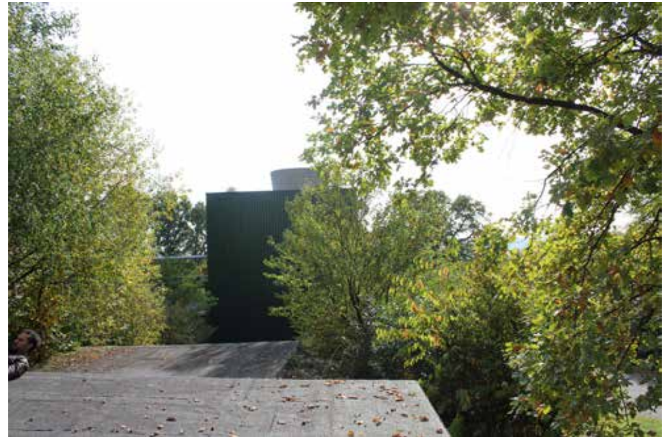
Abb. 59: Blick auf Schachthalle vom Dach des nördlichen Hauptlüftergebäudes
