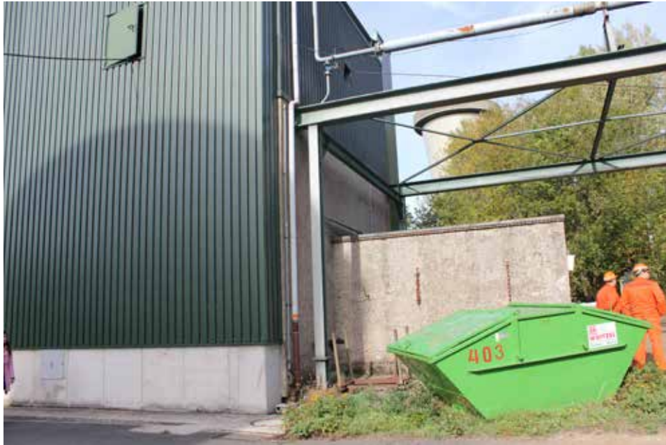
Abb. 58: Einhausung der Schachthalle
