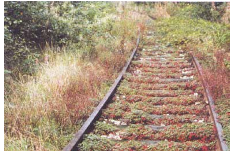
Abb.7: Spuren alter Eisenbahnstrukturen
