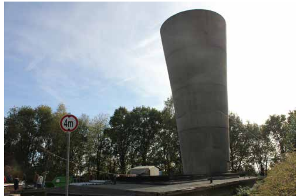
Abb. 67: Reservelüftergebäude im südlichen Bereich des Grundstücks
