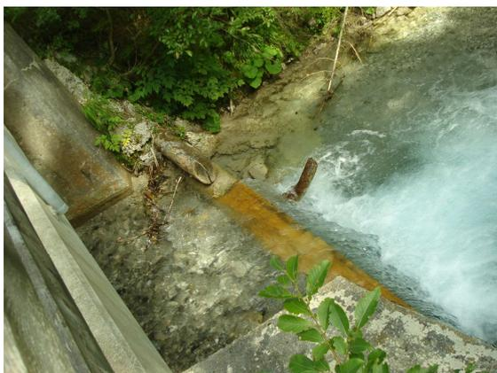
Abbildung 24: Brücke mit anschließender Schwelle(30-40cm) im Gösseringgraben
