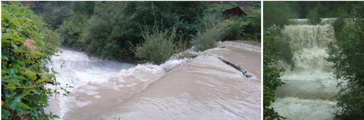
Abbildung 46: Überströmte Wehrschwelle des Kraftwerks Grünburg
