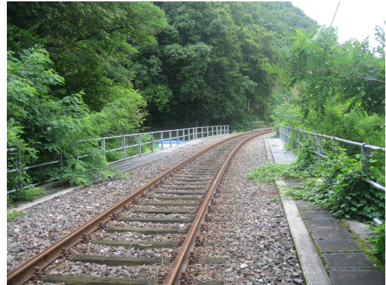
(b) Draufsicht der Brücke
