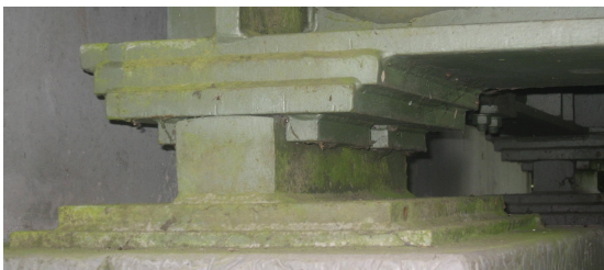
(a) Linienkipplager
