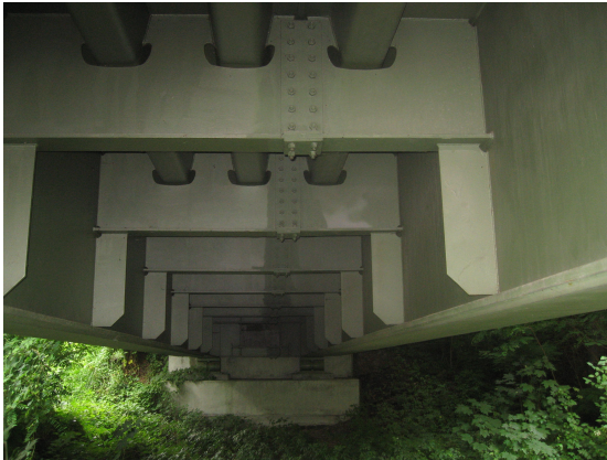
(a) Untersicht der Brücke
