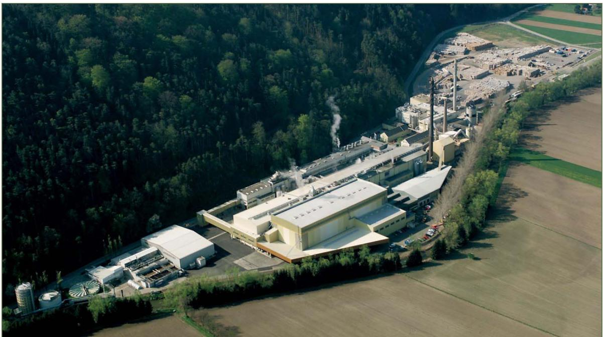
Abb. 1-2: Luftbild der W.Hamburger Papierfabrik in Pitten, v.r.n.l.: Alpapierlager, Papierfabrik, Abwasserreinigungsanlage [9]
