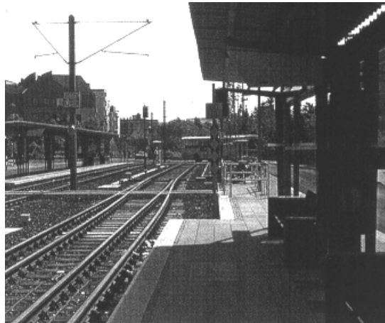
Abb. 47 – Bahnsteig mit Gleisverschlingung (Baunatal-Stadtmitte) [89]
