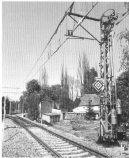
Abb. 48 – Trennstelle Gleichstromfahrleitung [88]
