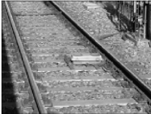
Abb. 57 – magnetische Fahrsperrung U-Bahn mit Oberleitungsbetrieb [eigenes Foto]
